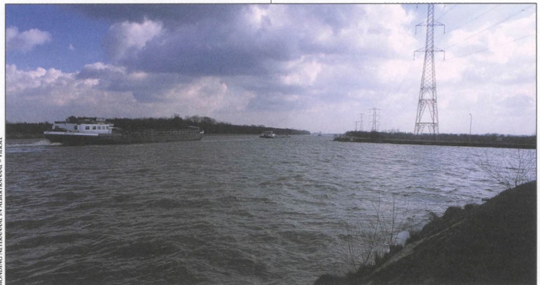
MONDING NETKANAAL IN ALBERTKANAAL – VIERSH
