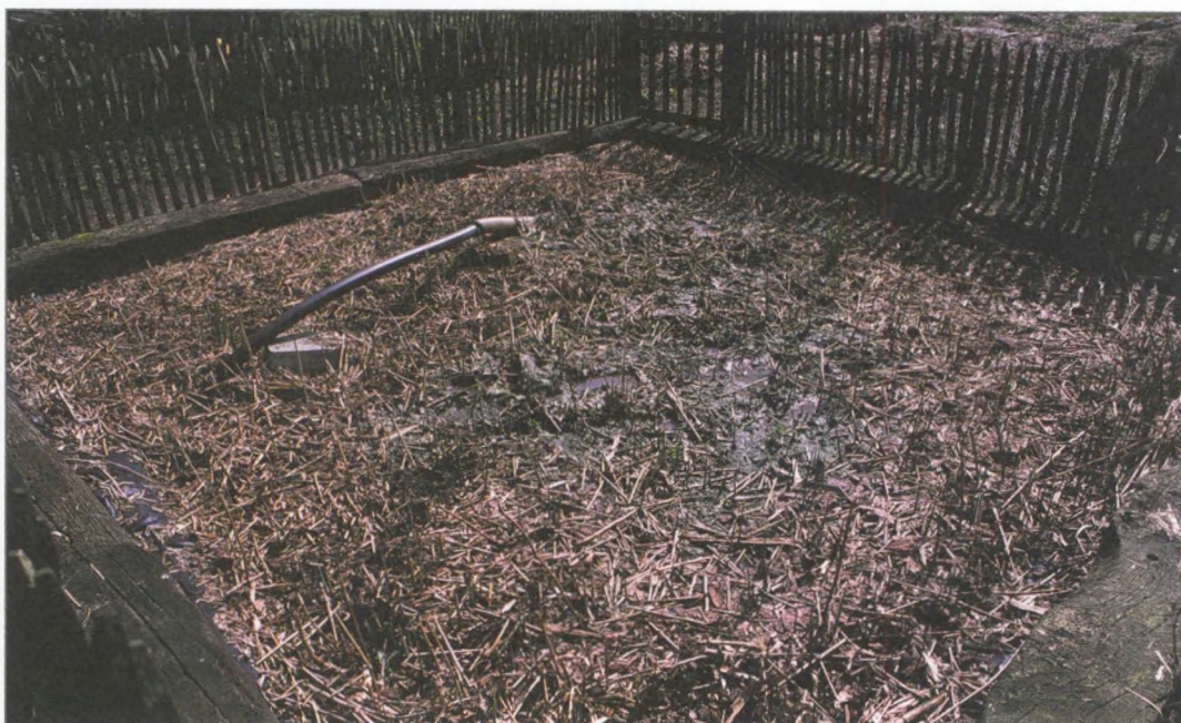
INDIVIDUELE BEHANDELIJGINGSINSTALLATIE (IBA) - LICHTAART
