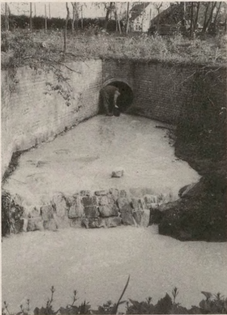
Loospunt Collector I, industrieterrein "De Bruwaan" te Oudenaarde
