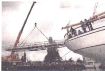
Het anker is gelicht en de gangway wordt weggehaald. Het grote werk kan beginnen.
