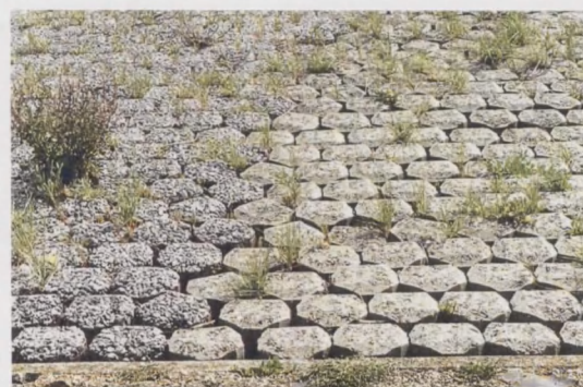
Foto 3: Betonzuilen met en zonder ecotoplaag (Pitpolygoonzuil)
