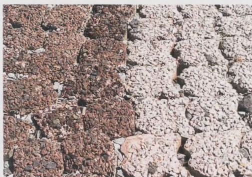
Foto 2: Betonzuilen met ecotoplaag (links Basalton, rechts Hydroblock)
