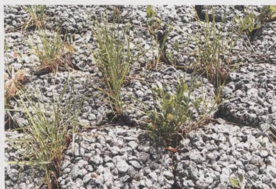
Foto 8: Betonzuil met ecotoplaag (Pitpolygoonzuil) en Gewone zoutmelde, Strandkweek en Spiesmelde
