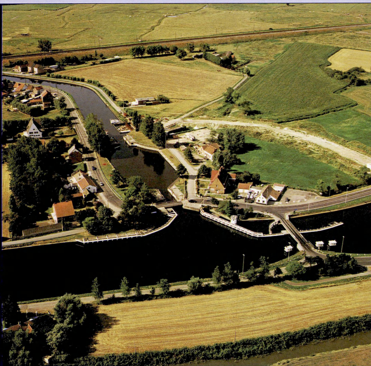
UDENBURG: HET PLASSEDALE-SLUIZENCOMPLEX
