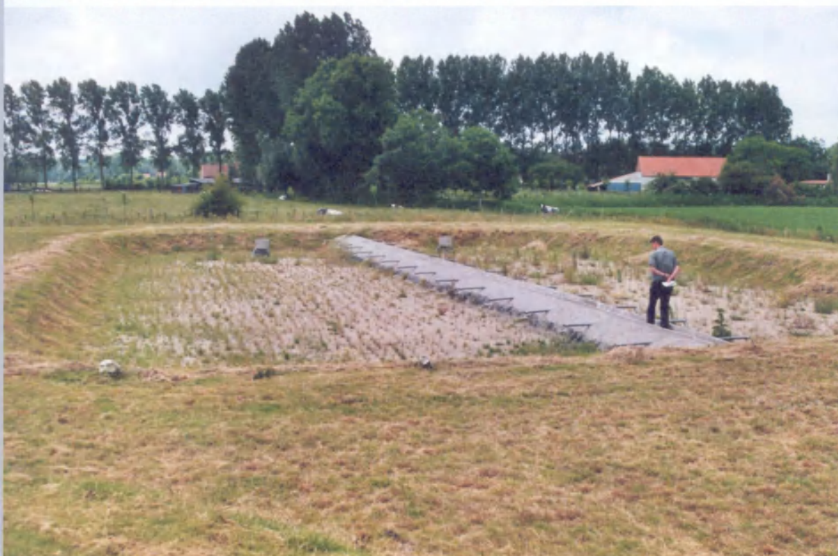
Aanleg van kleinschalige waterzuiveringinstallatie (KWZI) te Middelburg
