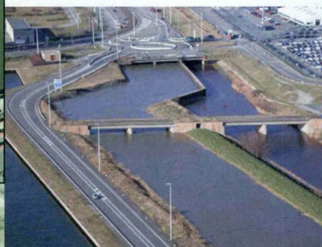
Schipdonkkanaal en Leopoldkanaal overwelfd in 3 kokers
