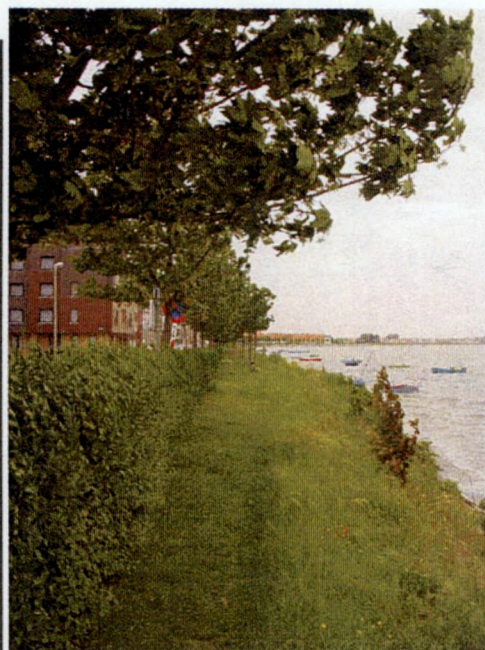
GLOOIING AAN DE NOORDKANT VAN DE SPUIKOM
