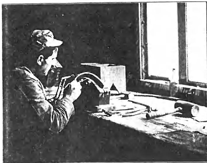
ATELIER DES TURBINES, aux Forges et Chantiers de la Méditerranée : Soudage et Assemblage des ailettes.
