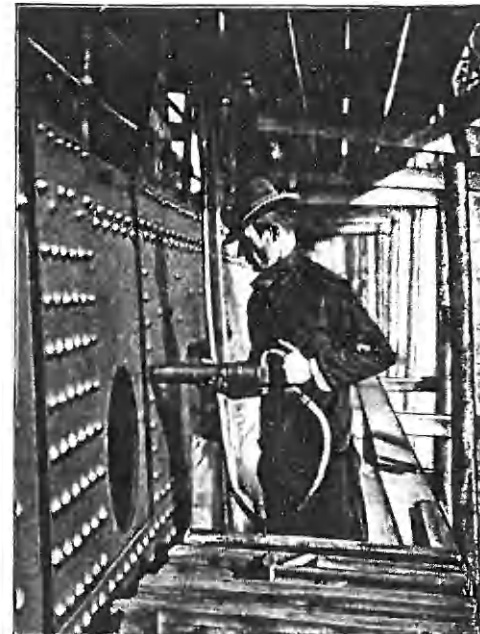
RIVETAGE des boulons à l'air comprimé.
