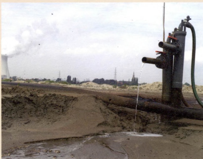
15 december 2000. Draineringspompen zuigen het water uit de bodem. Foto Stefaan Van Hul
