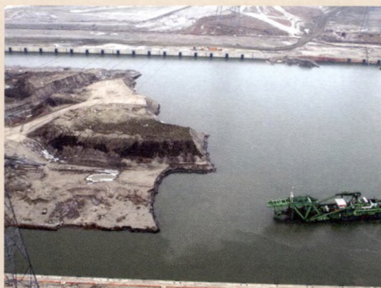
21 december 2004. Stukje bij beetje wordt het dok uitgebaggerd en wijkt de poldergrond voor water. Foto Frederik Weekx
