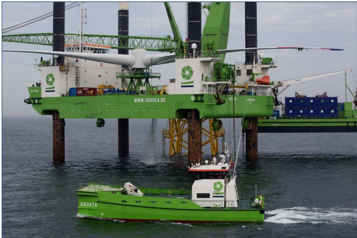
Figuur 4-3 Onderhoudsschip Aquata in actie op Thorntonbank
