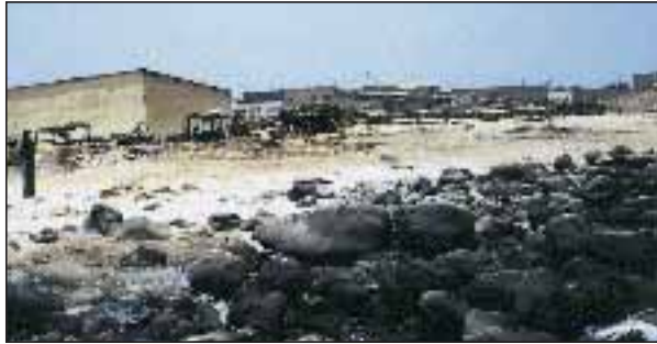
Décharge jouxtant l'usine. Elle reçoit les eaux d'écoulement de l'usine et les déchets ménagers du quartier.
