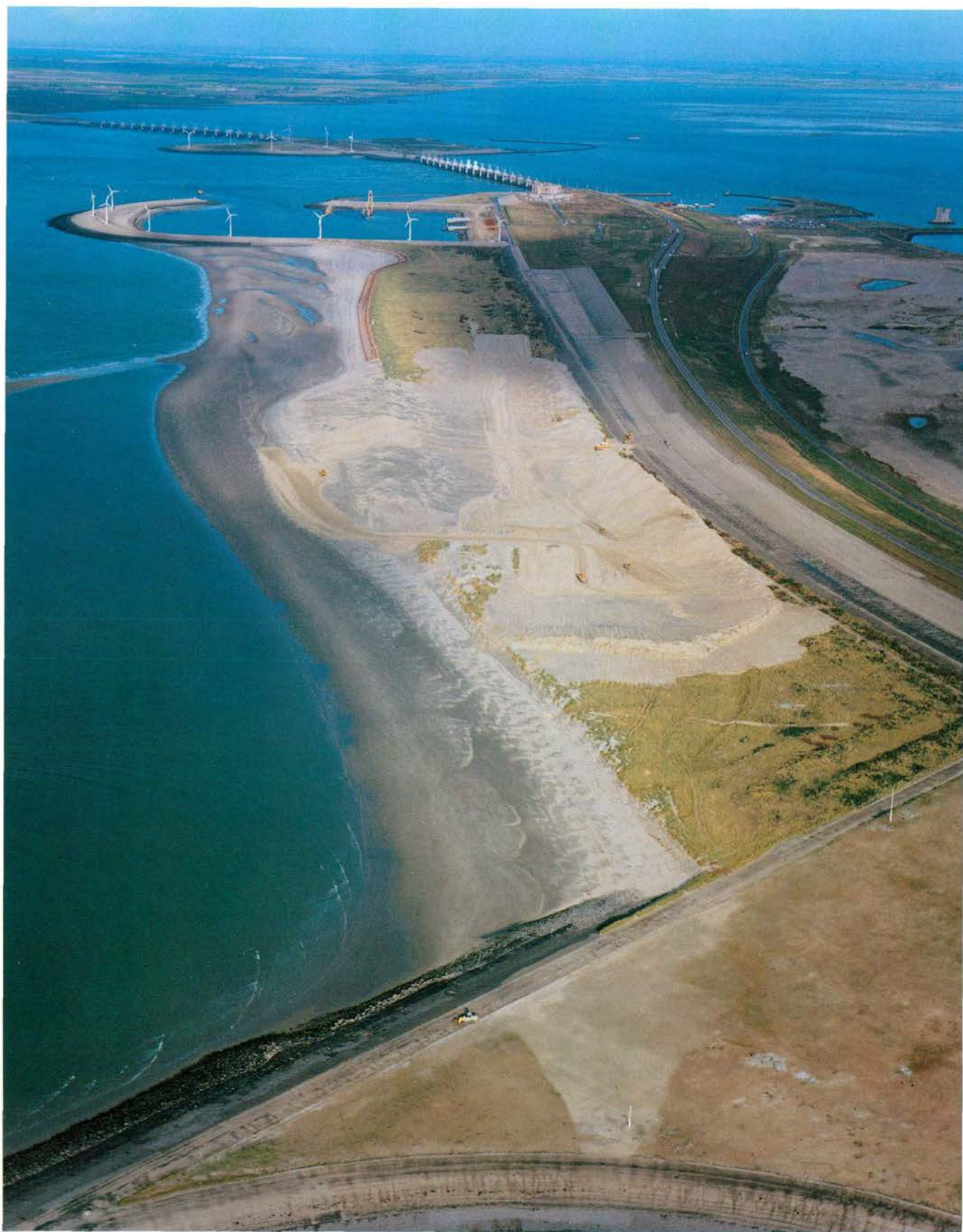
foto : Aan de zeezijde van het eiland Neeltje Jans zijn bulldozers bezig met de aanleg van de slufter.
