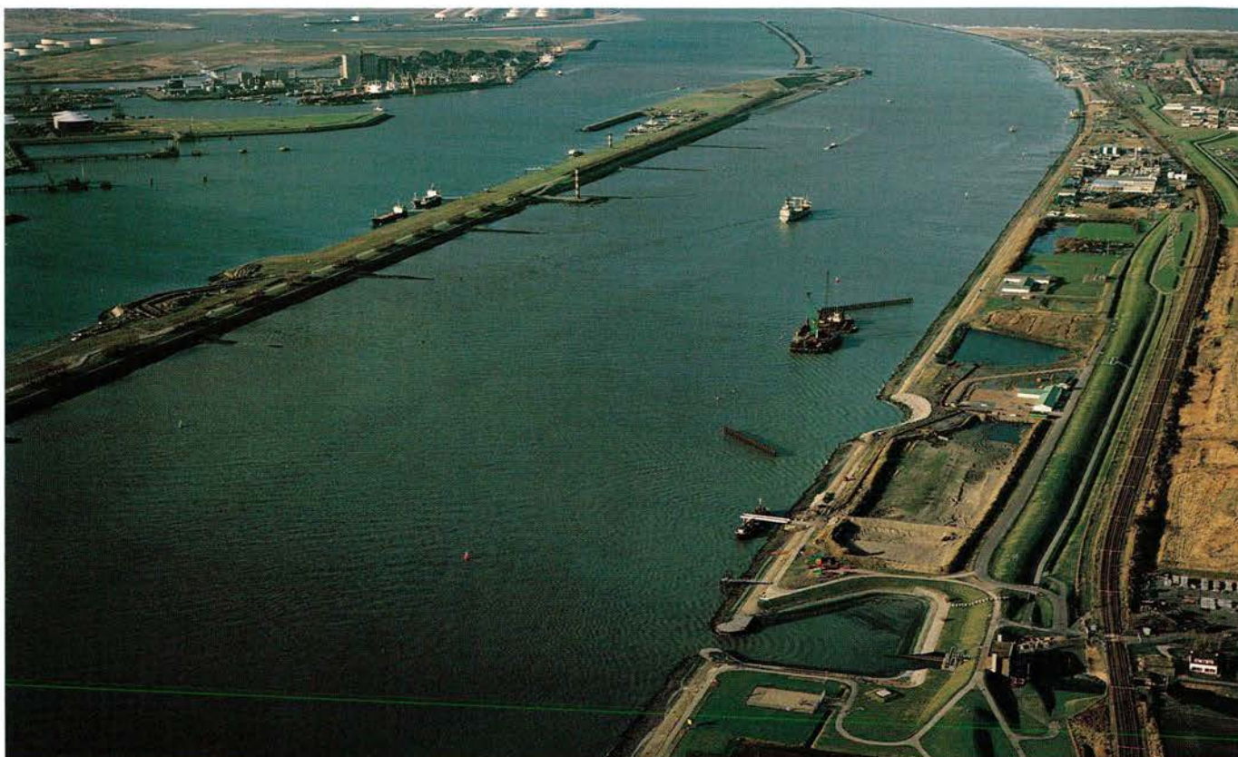
foto: Januari 1992, aan de noordoever zijn de eerste damwandplanken geplaatst.
