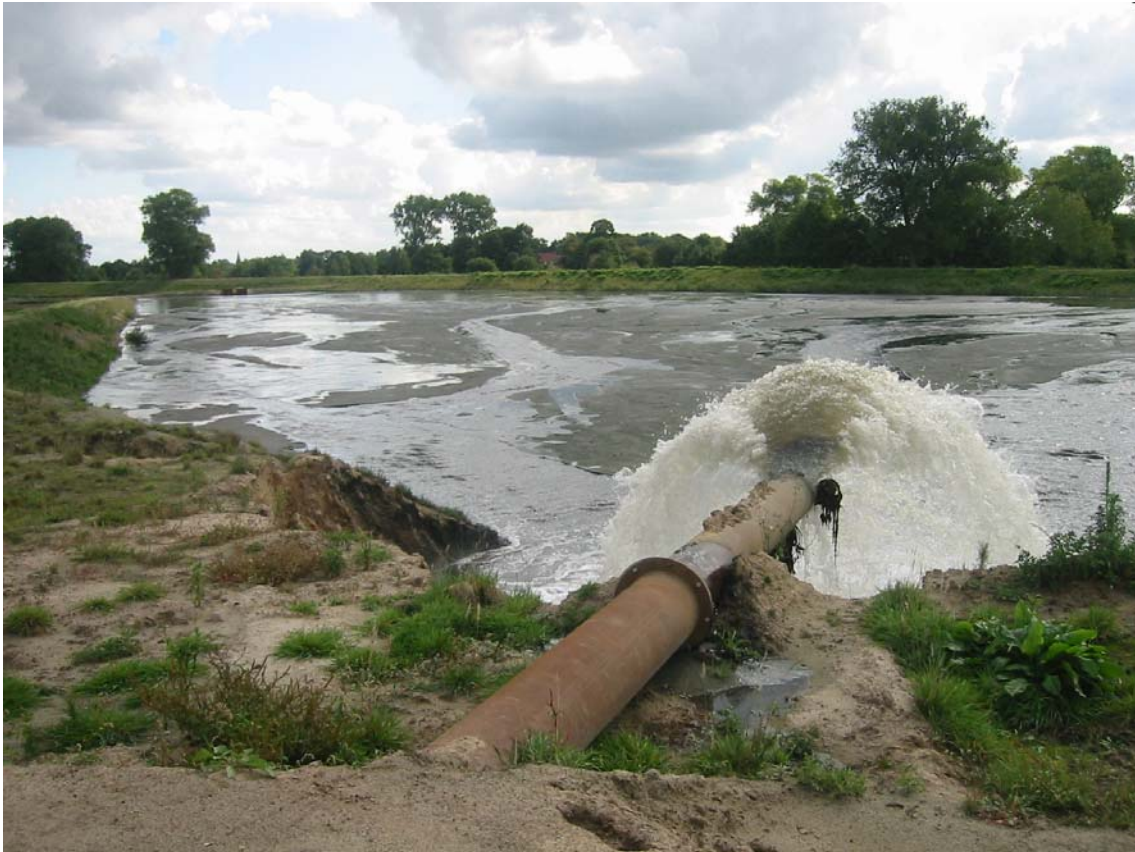
Figuur 2: Zandscheidingsbekken: de baggerspecie wordt via een hydraulische pomp in het bekken gebracht. Vooraan in beeld bezinkt het zand in het zandbekken, achteraan in beeld ligt het bezinkingsbekken voor de slibfractie.
