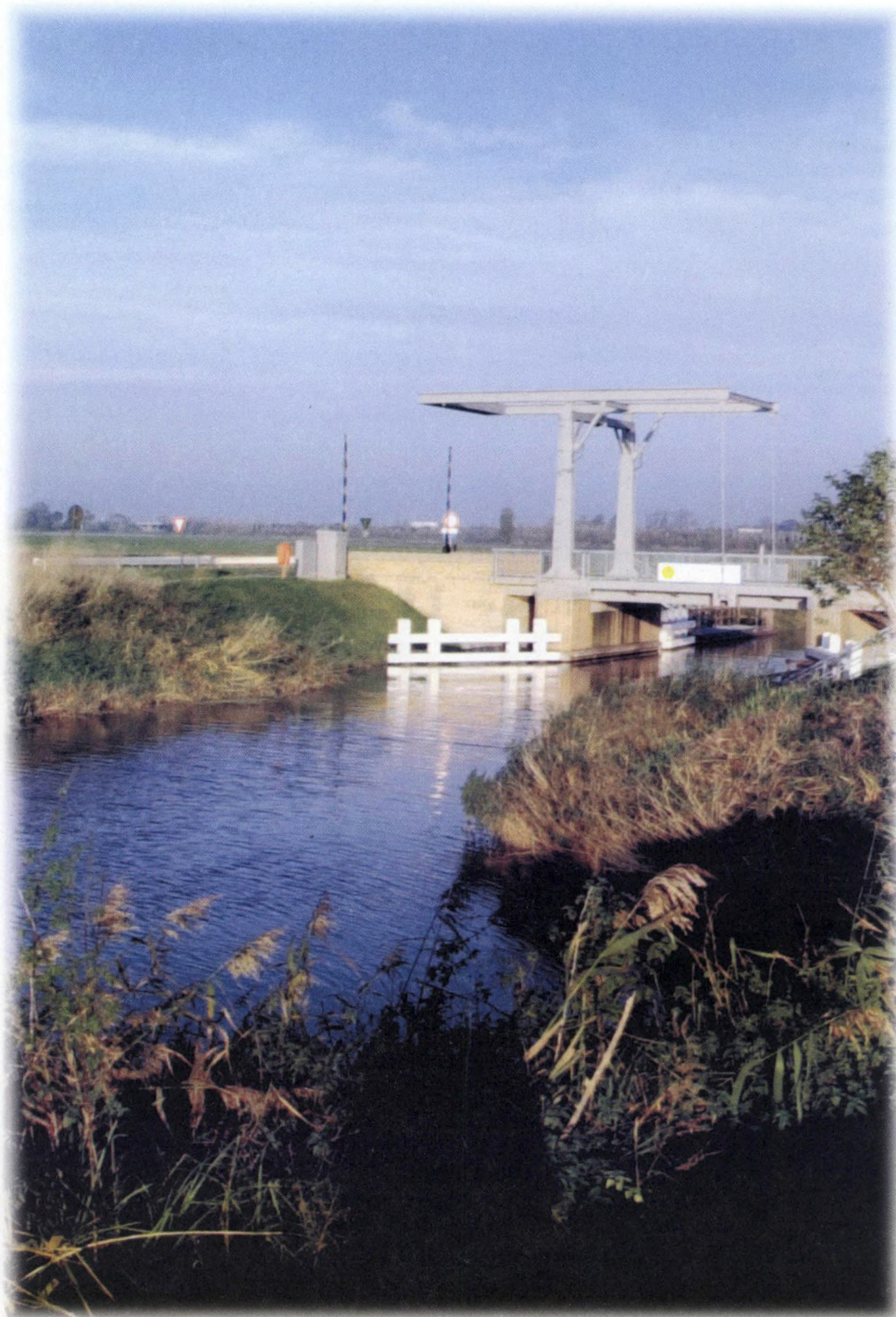
LOKANAAL VEURNE - STEENKERKEBRUG
