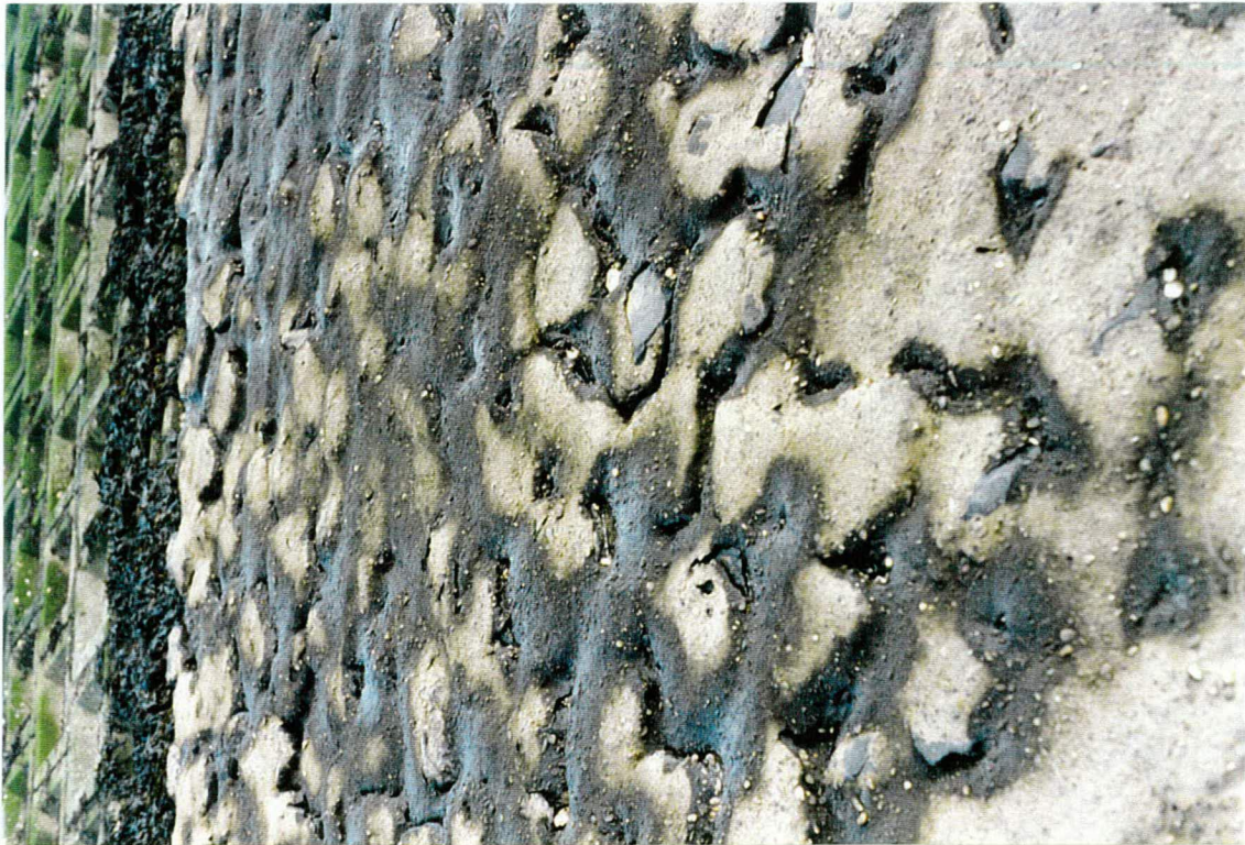
Foto 3 Vochtplekken op het talud, maar geen uittredend water geconstateerd
