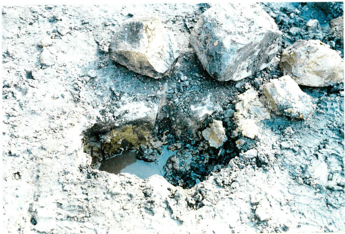
Foto 6 Het onderste gat stroomt vol met water nadat het talud is opengebrouwen
