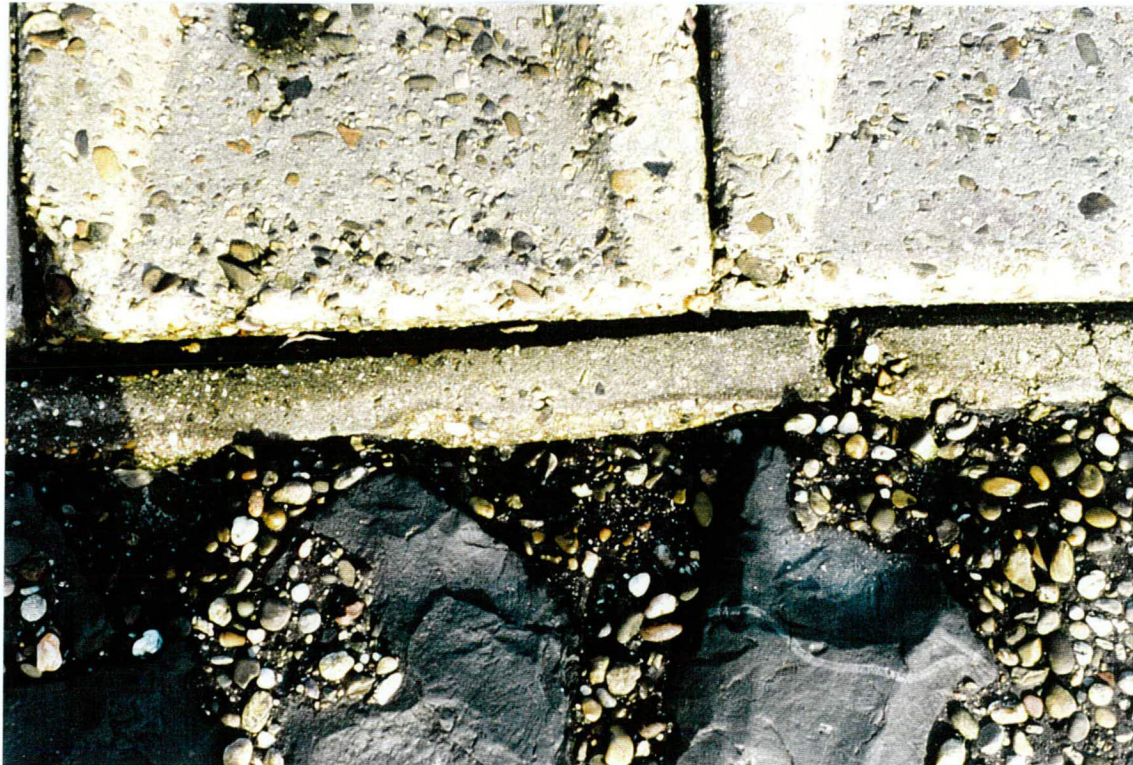
Foto 4: Overgangsconstructie van gepenetreerde basalt naar Haringmanblokken
