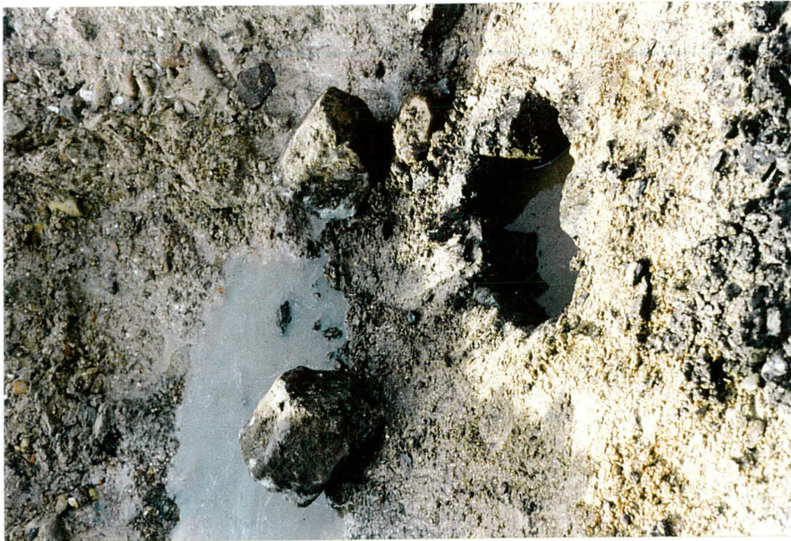
Foto 7 Gat in het talud onder het zand. Links stroomt het gat in het voorland vol met water, in het gat in de bekleding is water gegoten; dit stond droog.
