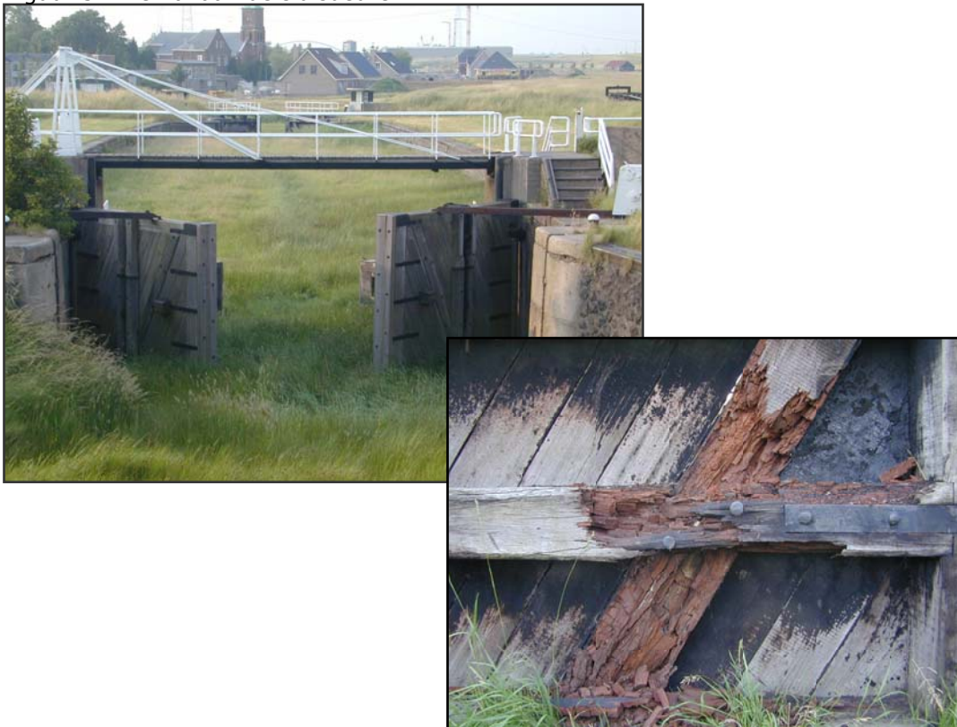
Figuur 5.1 Verval aan de sluisdeuren
