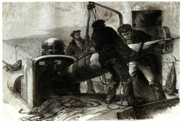
Portée par une enveloppe de toile, elle est suspendue par des chaînes à une potence. Deux hommes la dirigent en face de la culasse du tube et puis la poussent dans son logement. C'est une petite charge de poudre qui lance, par son explosion, la torpille hors du tube.
