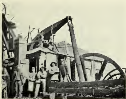
Machine d'extraction de la houillère de Farme, système Newcomen, érigée en 1810, encore en fonction aujourd'hui (1905).
