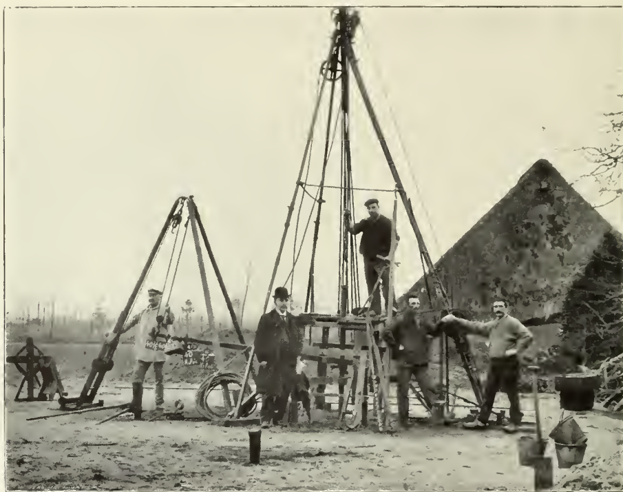
Matériel portatif permettant de sonder à 40 mètres.
