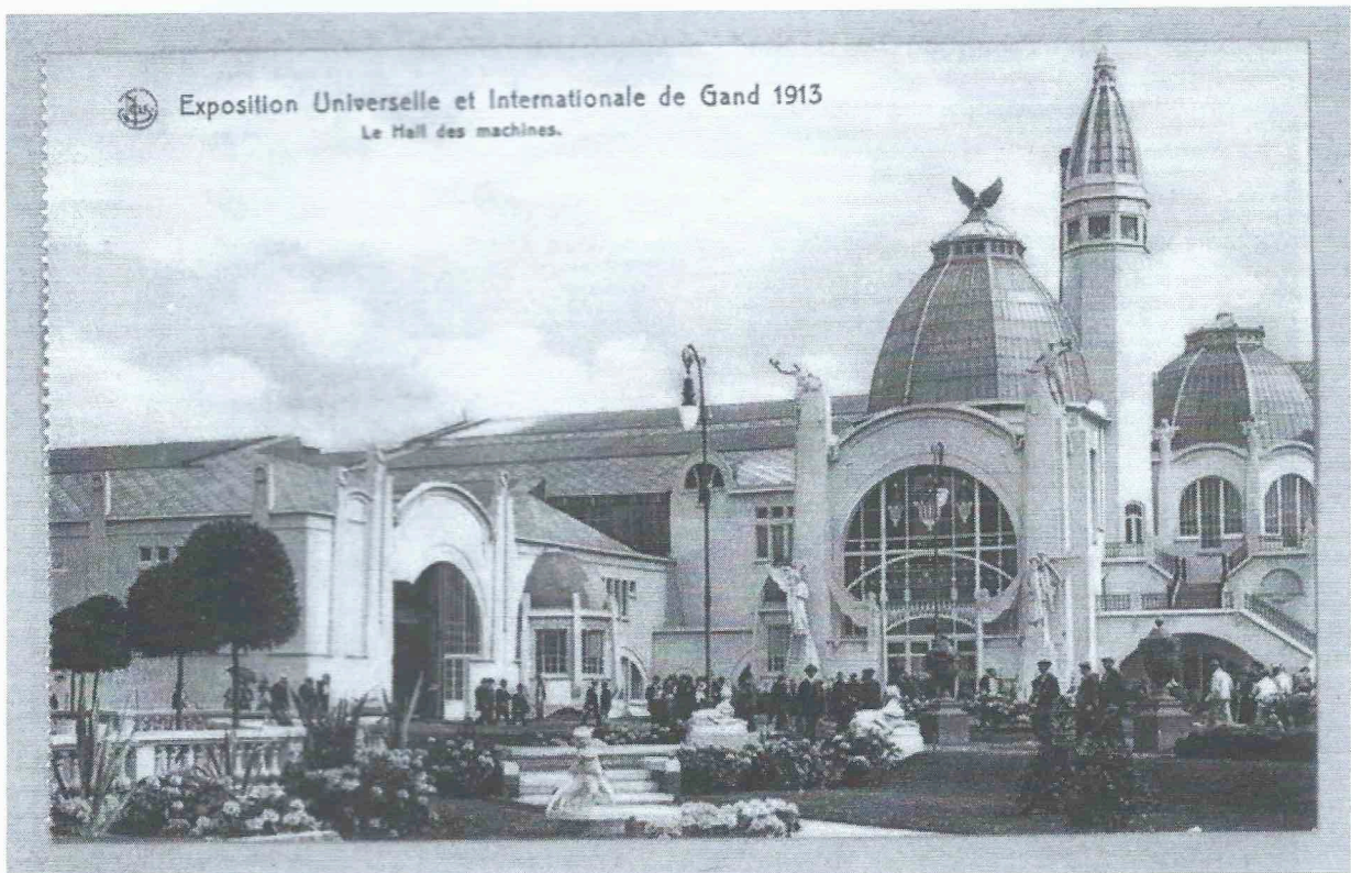
De machinehal, het lichtpaleis en gebouw voor kleine werktuigen was het enige paviljoen in art nouveau stijl. Architect was Geo Hendrick (Bibliotheek UGent)
