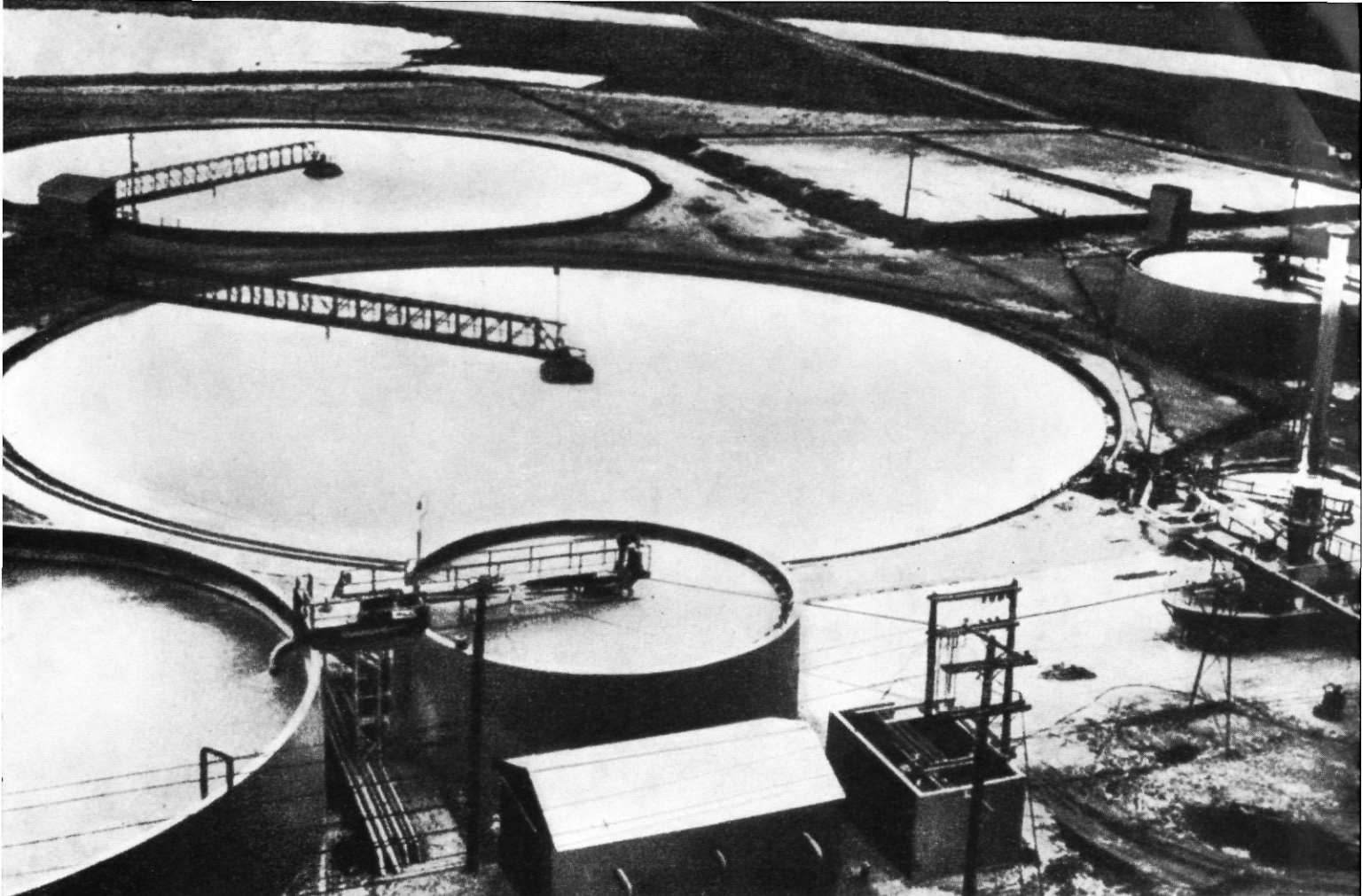
Magnesiumafschenkbakken in een Amerikaanse fabriek (Foto U.S.I.S. naar "La Mer" blz. 343 ; werk gepubliceerd door de Librairie Larousse onder leiding van V. Romanovski en Claude Francis-Bœuf)
