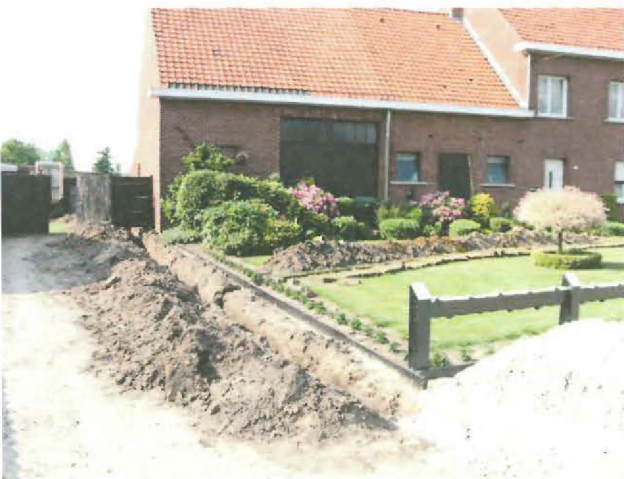
Afkoppelingswerken in een tuin in de Mosselgoren
