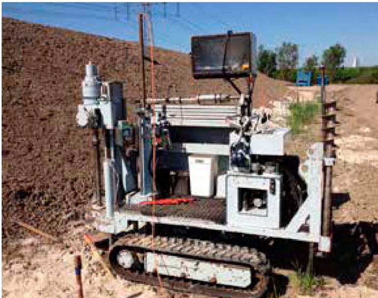
Plaatsing multi-sensormodules door mini sondeerrups
