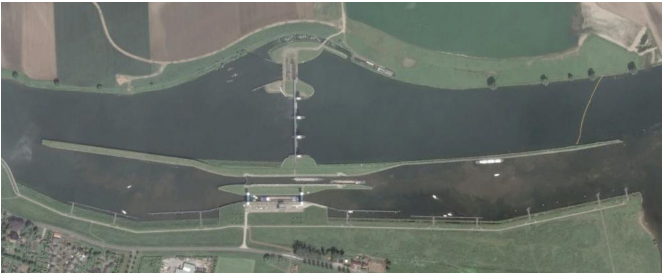
Figuur 34 – Sluizencomplex Lith: sedimentpluimen in de voorhavens door opwoeling van de gesedimenteerd sediment als gevolg van schroefwerking
