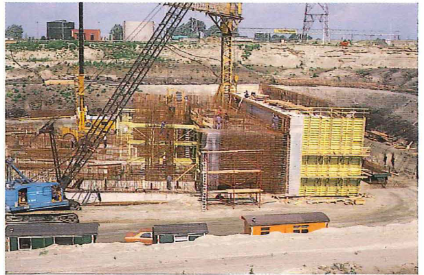
bouw tunnelgedeelte linkeroever
