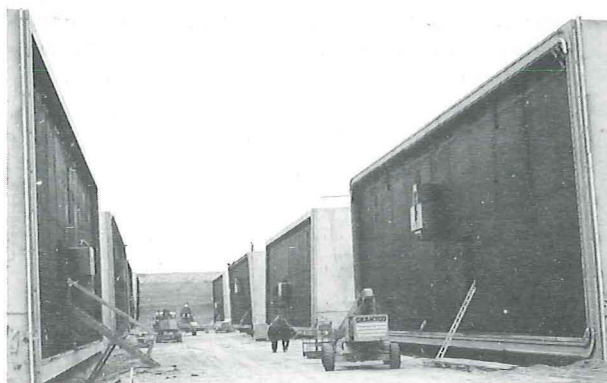
kopschotten en oplegkonsoles afgewerkt
