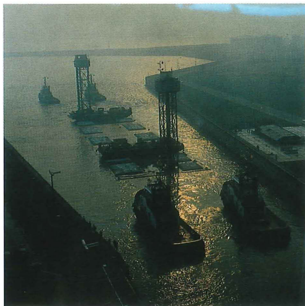
transport eerste tunnelement door Kallosluis op 09.09.89
