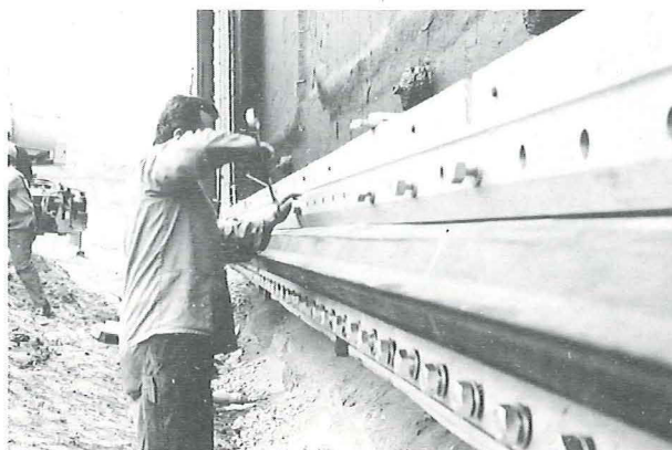
aanbrengen van Gina-profiel
