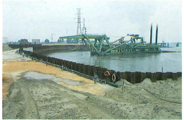
aanleg zinksleuf op linkeroever met cutterzuiger
