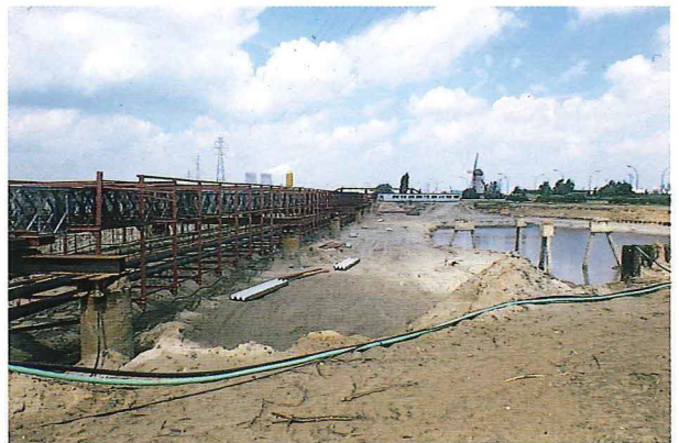
leidingenbrug en vorige fundering hoogspanningsmast
