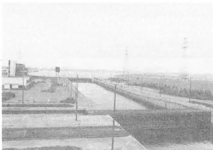
Zicht op de Kallo-sluis en het Waaslandkanaal (Bron foto : M.O.W.)
