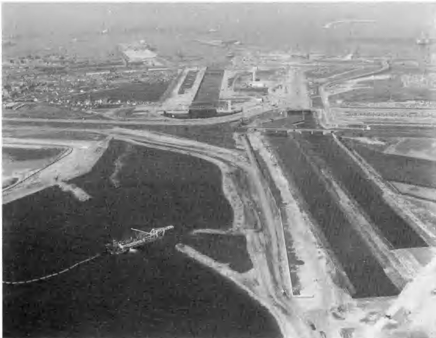
Algemeen zicht op de nieuwe zeesluis te Zeebrugge. Het grondmassief tussen de sluis en de dokken in de achterhaven werd ondertussen weggebaggerd.
