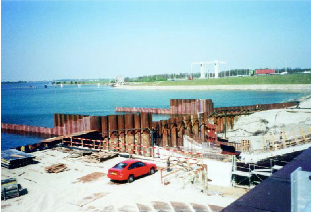
De aanleg van het doorlaatmiddel in de Zandkreekdam.
