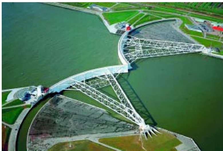
Foto: Maeslantkering, sluitstuk van de Deltawerken.
