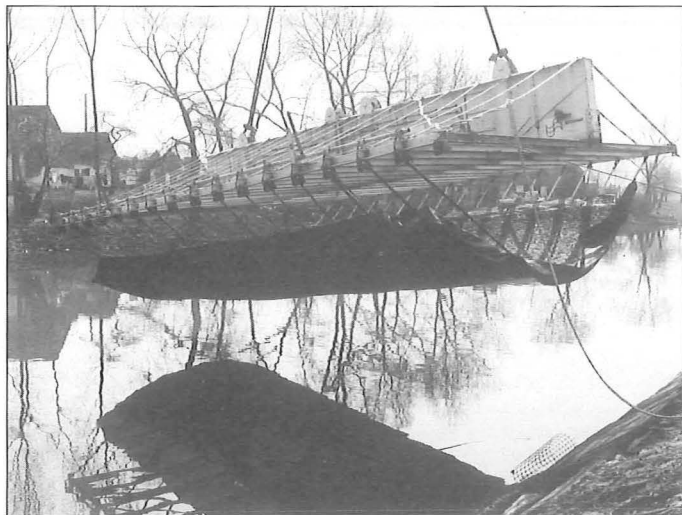
Foto 3: Detailopname van de steenasfaltmat met plaatsingsmethode voor de werf te Zomergem. Vooraan de gebakeliseerde platen met daarop het opgespannen filterdoek, een eerste deel geprefabriceerde mat en onderaan de eindbalk met spankabels naar de lieren aan de overzijde van het kanaal.
