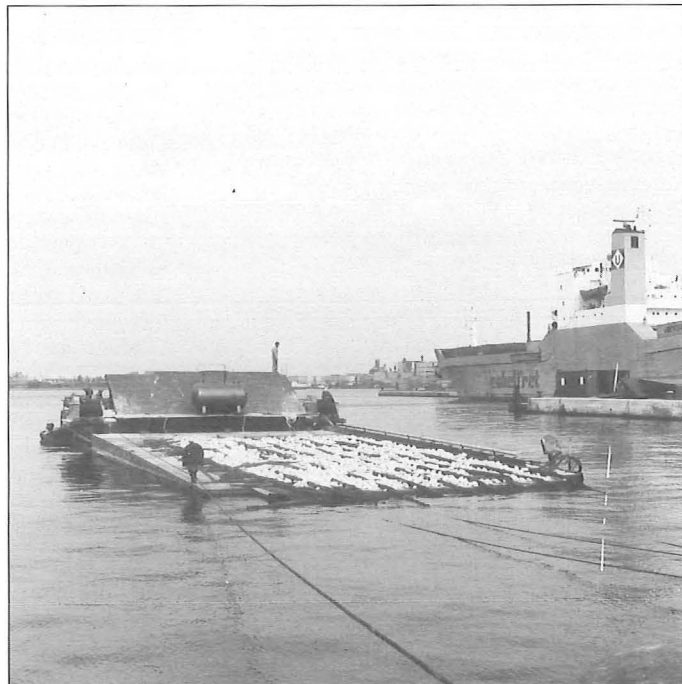
Foto 2: Algemeen zicht op afzinkponton ingezet in de Haven van Antwerpen. Benevens het plaatsen van geprefabriceerde open steenasfaltmatten kunnen ook de klassieke zinkstukken, zoals hier zichtbaar, alsmede schanskorven op doek afgezonken worden.
