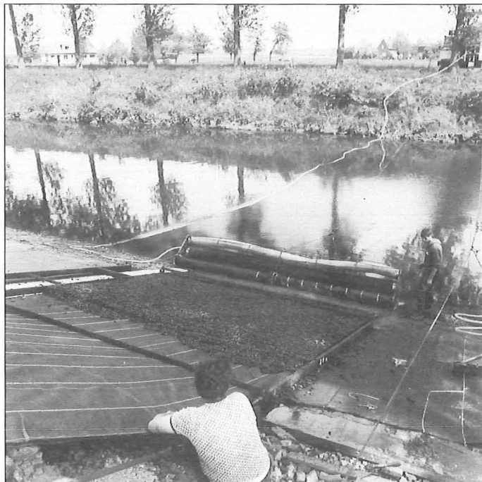
Foto 1: Detailopname van een geprefabriceerde open steenasfaltmat vóór afzinken d.m.v. een legframe. Duidelijk zichtbaar zijn de belangrijkheid van de op voorhand berekende toegelaten kromtestraal der mat alsmede de overlappanten van het filterdoek.
