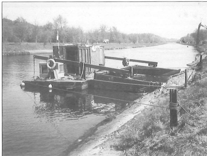
Foto 4: Algemeen aanzicht van het drijvend ponton met caisson tijdens de uitvoering der herstellingswerken langsheen het kanaal Nimy-Blaton. De kanaalwaterstand binnen het caisson is nog niet verlaagd.
