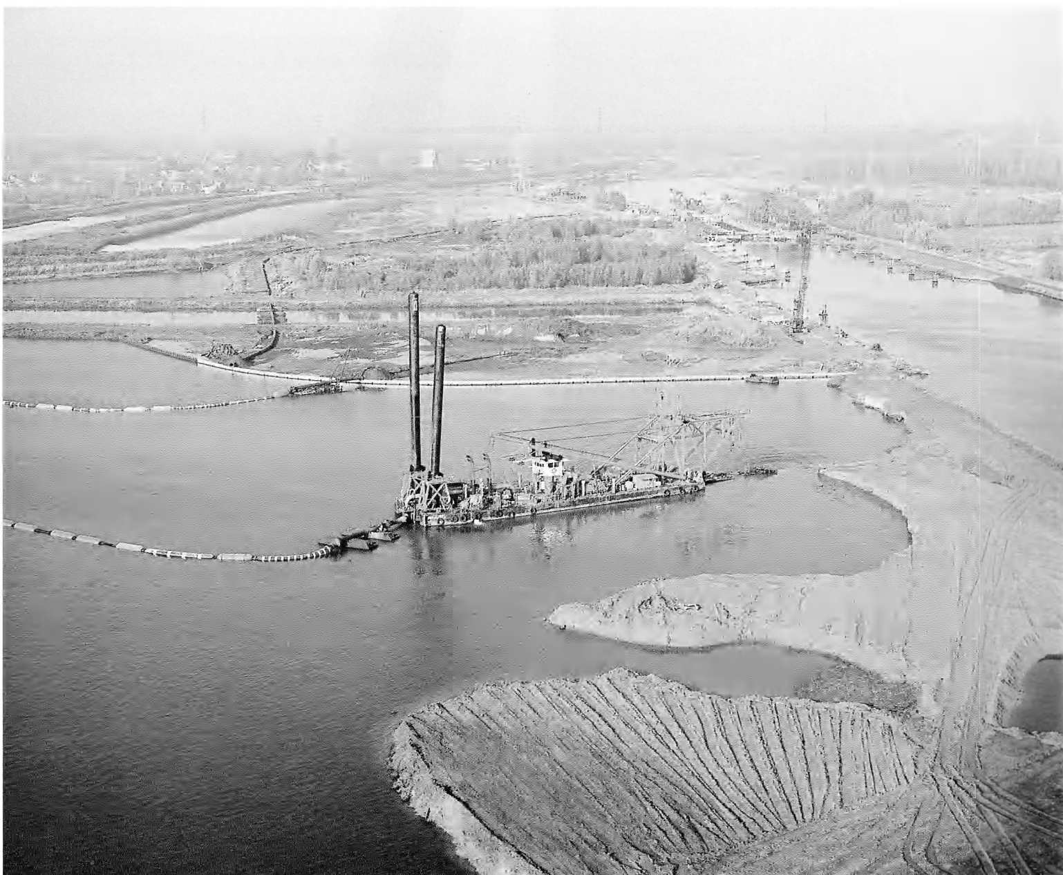
Foto 2. — Baggeren van de omlegging.
