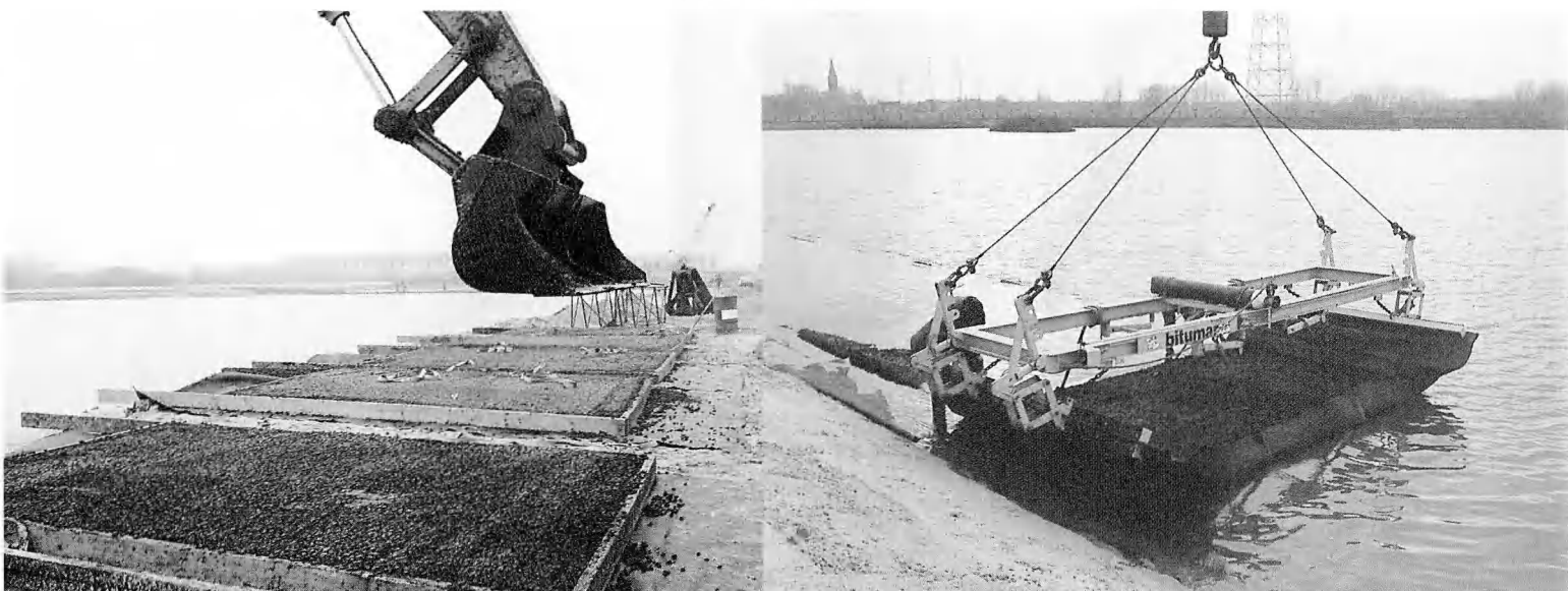
Foto 17. — Maken en leggen van gevezelde open steenasfaltmatten.
