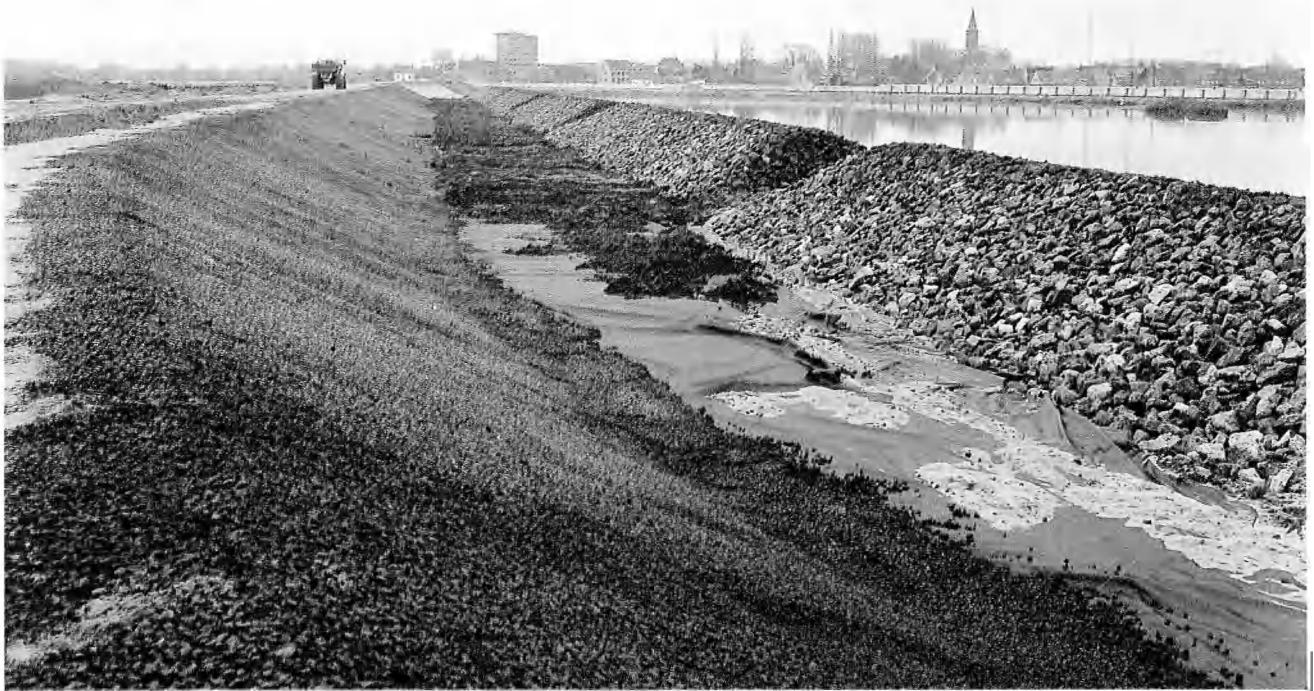
Foto 19. — Vooroever (natte strook): achtertalud in opbouw.
