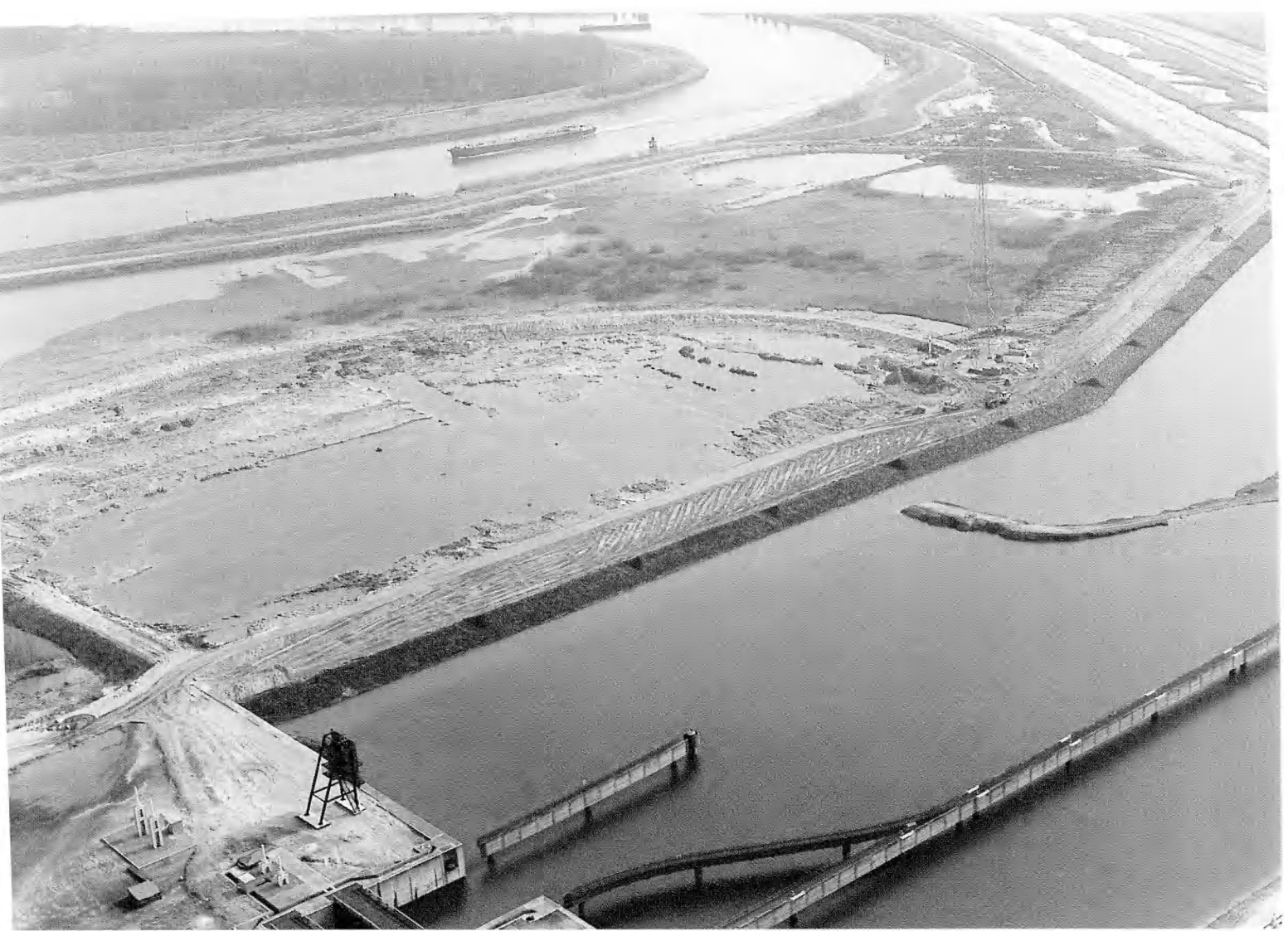
Foto 18. — Kunstmatige vooroever bestaande uit gepenetreerde breuksteen met verstevigde teen uit gevezelde open steenasfalmatten.
