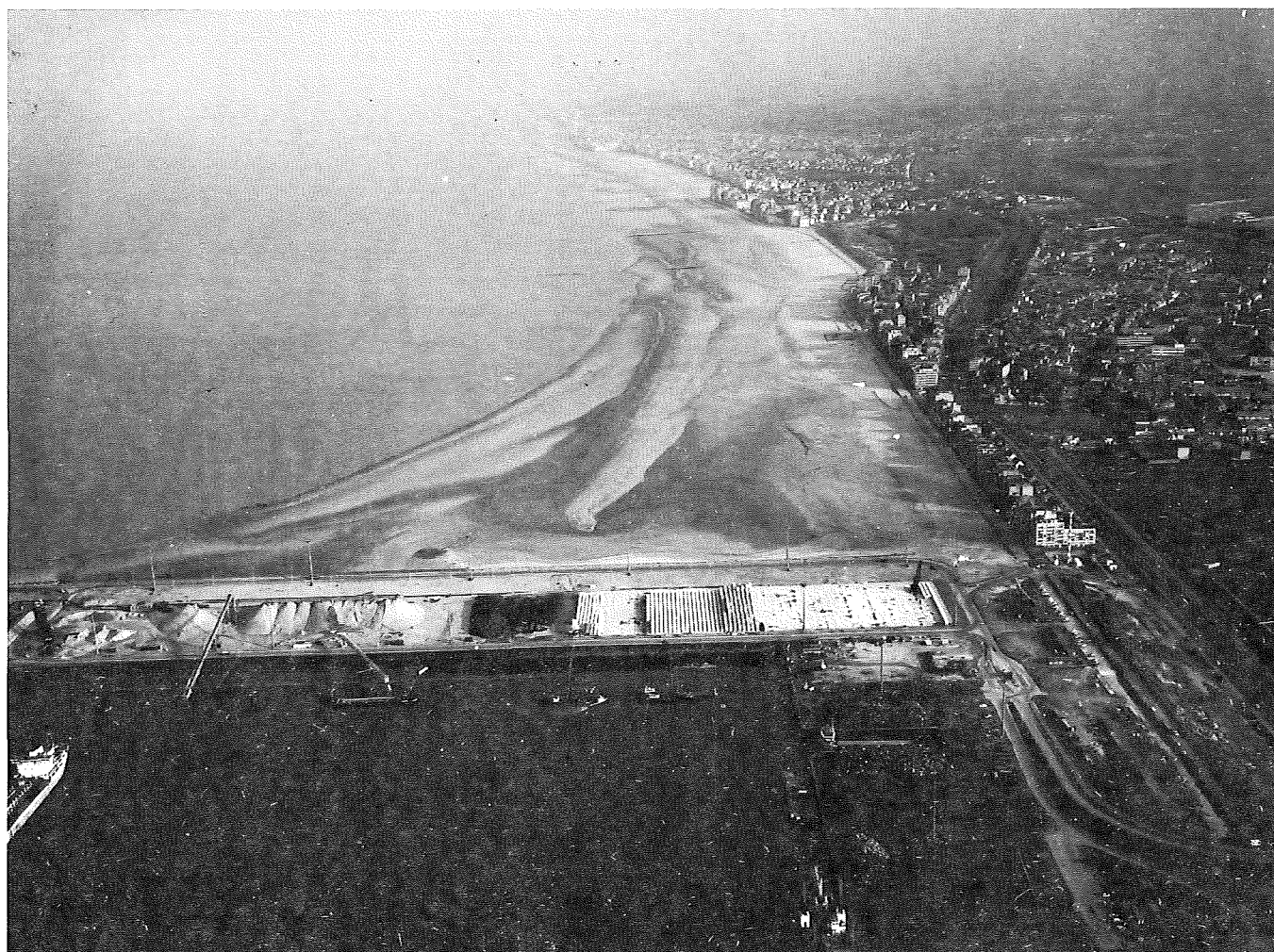
L'amélioration du littoral est ; à l'avant-plan, le terrain réservé à la fabrication de blocs de béton.
