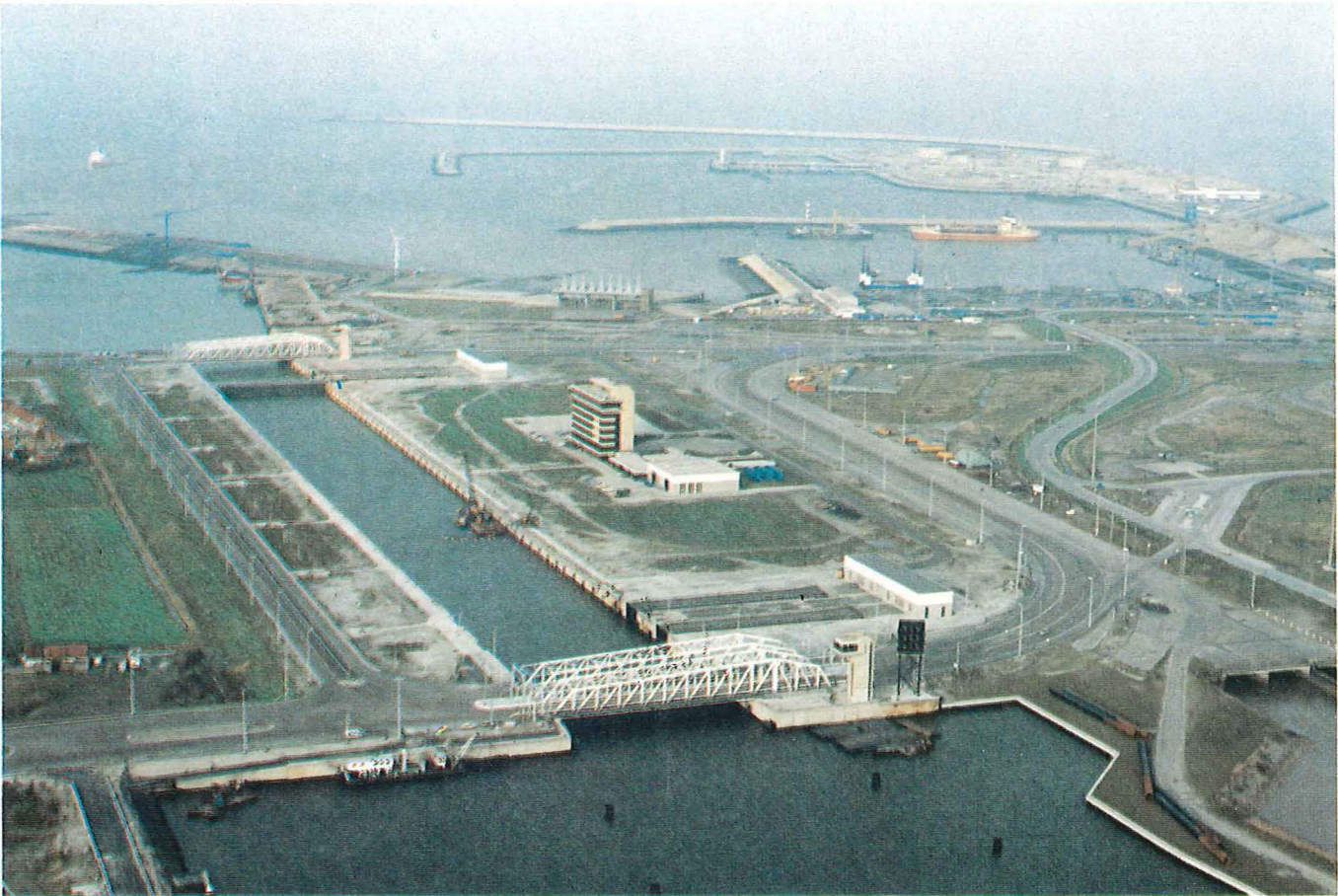
La nouvelle écluse P. Van Damme.
