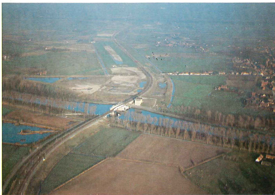
Pont de chemin de fer sur le canal Baudouin à Dudzele au sud du zoning industriel.
