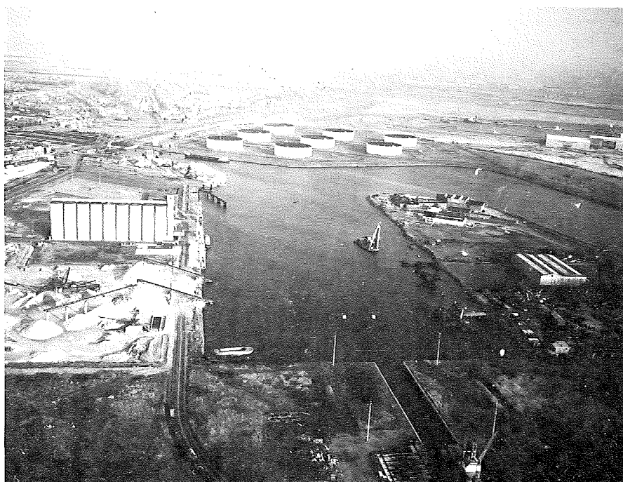
Le dock Prince Philippe avec la nouvelle cale radoub.
