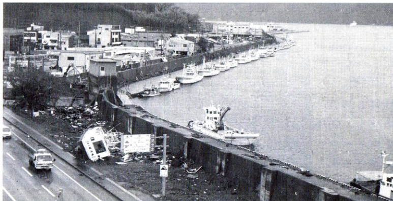
〔図 2-26〕 破壊されなかった宮古市の堤防。宮古市役所のそばにある鉄筋コンクリート造の堤防。鉄筋で補強されているため、破壊されなかった
