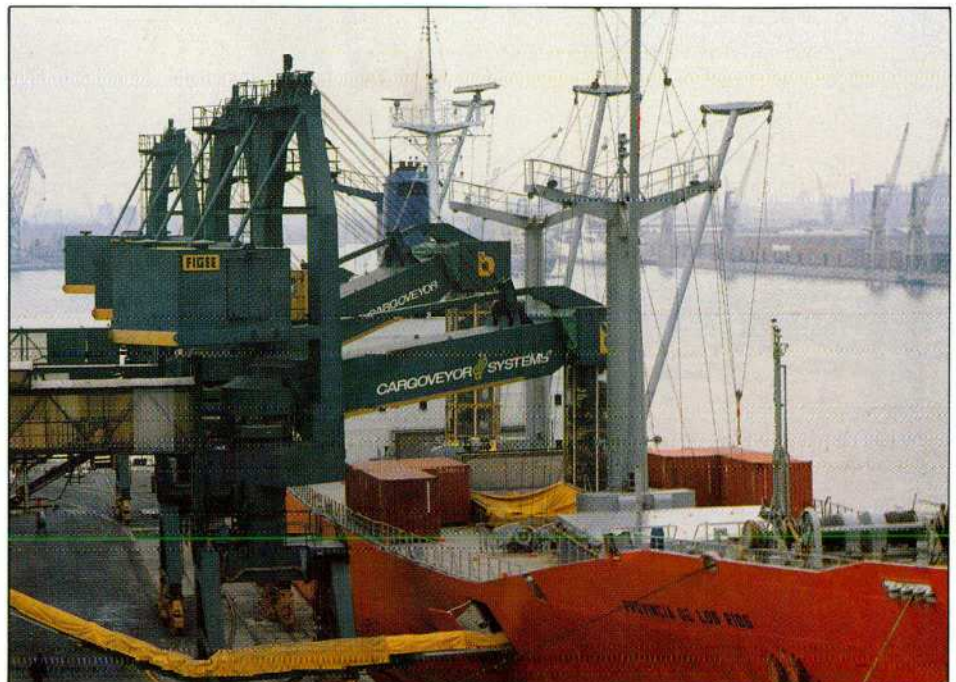
De losinstallaties van Belgian New Fruit Wharf zijn verbonden met een computergestuurd transportbandensysteem.
