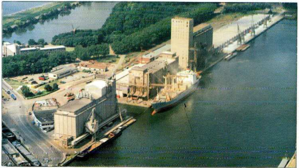
Het graansilobedrijf Samga aan het Amerikadok heeft een opslagcapaciteit van 120.000 ton.
