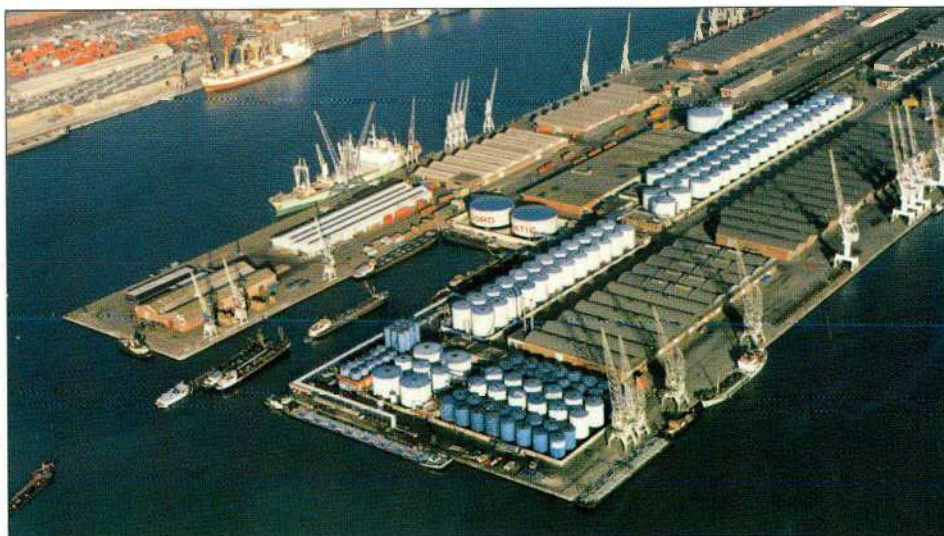
De tankinstallaties van Noord Natie hebben een capaciteit van 190.000 m 3 .
