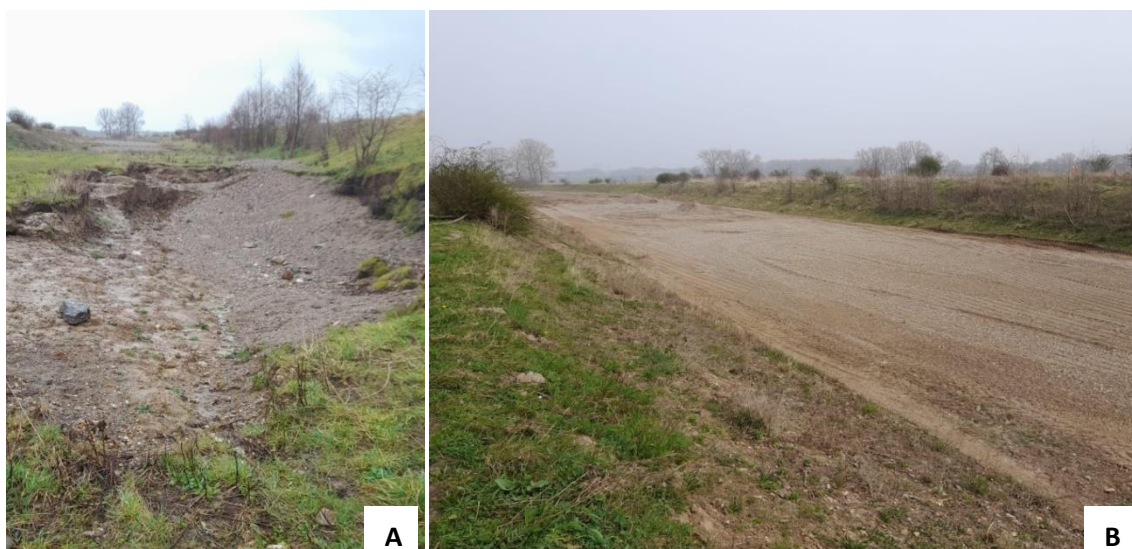
Foto 3.2 (A) Grindgat in de hoogwatergeul van Mazenhoven na hoogwater van juli 2021 en (B) de opgevulde hoogwatergeul ter bescherming van een aardgasleiding (© Natuurpunt Maasmechelen).
