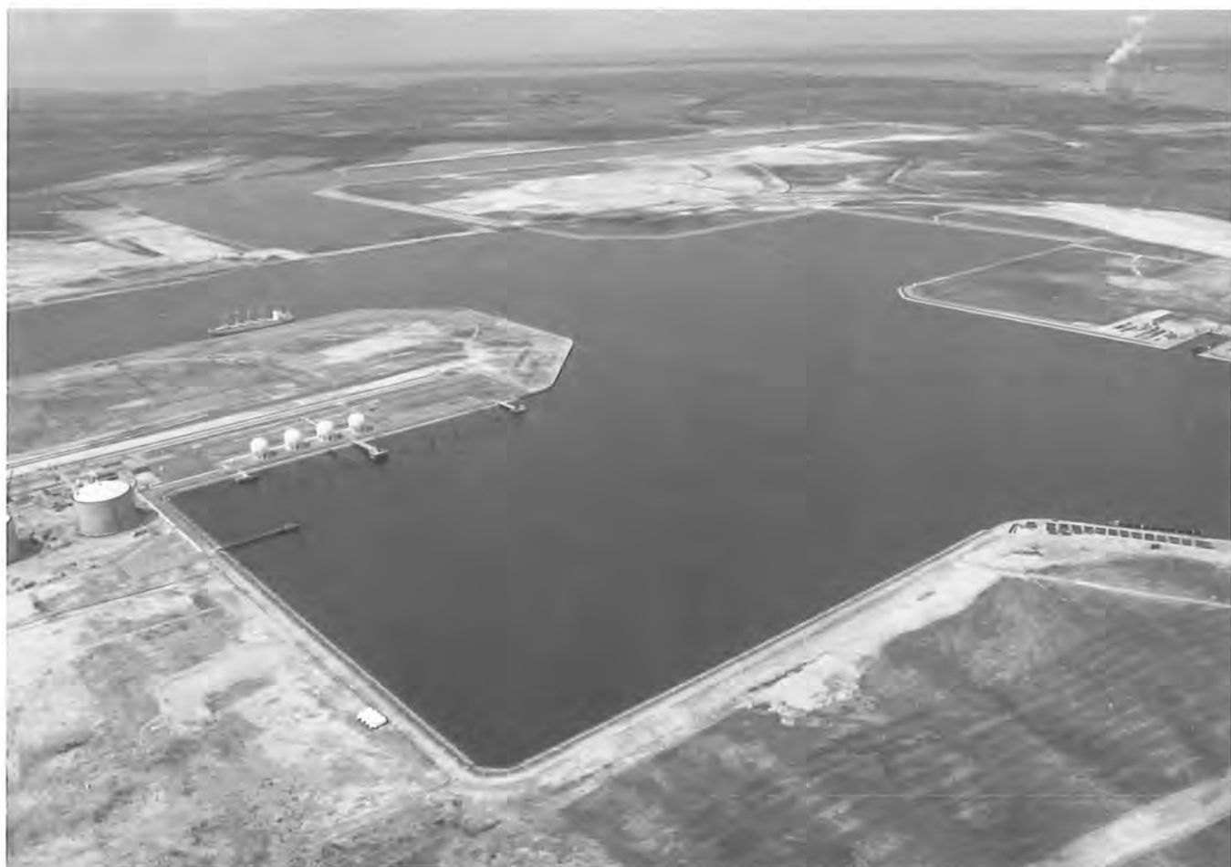
Vue générale sur les bassins du port et environs. A gauche les réservoirs de stockage de A.G.T. le long de la darse sud.
