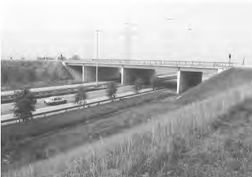
Viaduc dans la route nationale Melsele-Kallo au-dessus de la liaison Anvers-Côte maritime.
