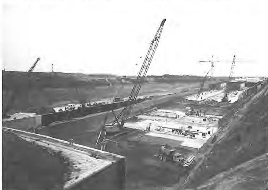
Vue générale du puits de construction des tunnel routier et ferroviaire sous le Waaslandkanaal (extrémité sud).
