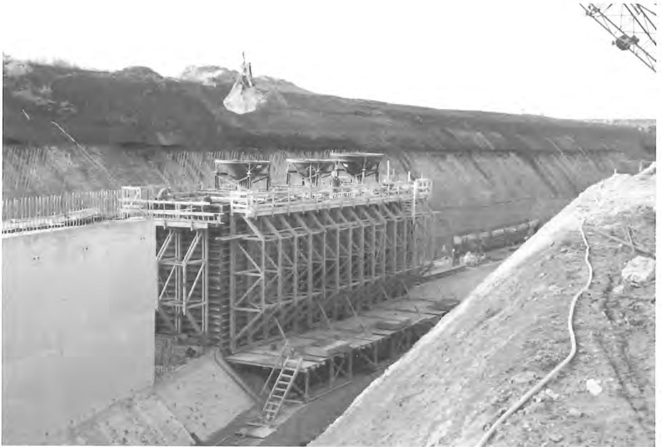
Le bétonnage des murs de quai.
