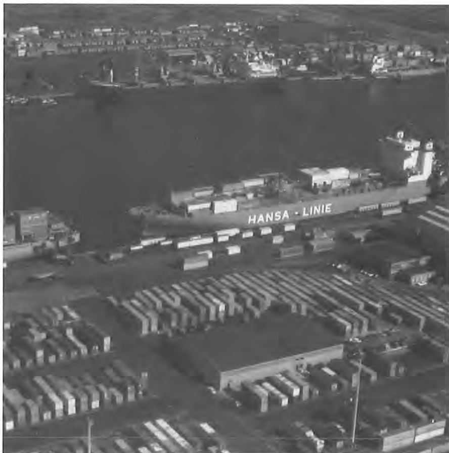
Vue partielle du Bassin Churchill avec des terrains réservés à la manutention des conteneurs.
