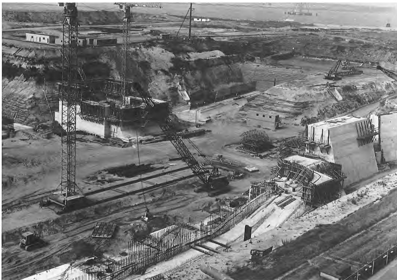
Terrassements et premiers travaux de bétonnage (juillet '83)
