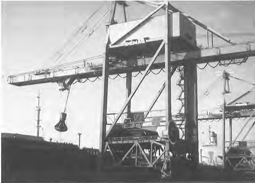
Les nouveaux ponts transbordeurs de la Stocatra.
