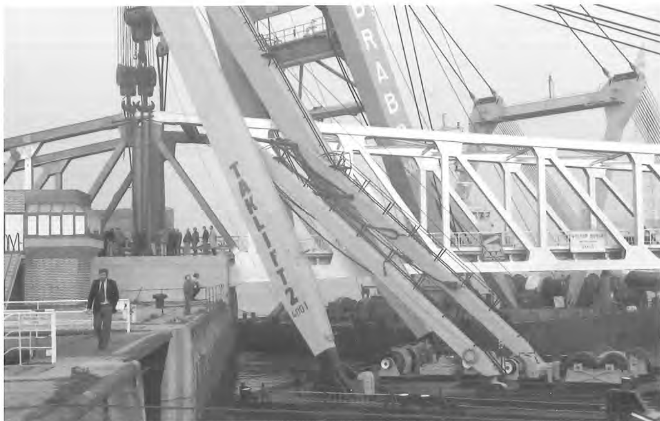
Positionnement du pont sur la tête aval de l'écluse de Zandvliet.
