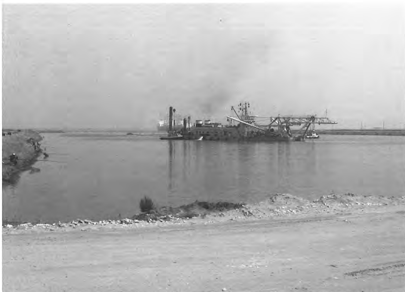
Bassin dit «Vrasenedok» en cours de dragage.
