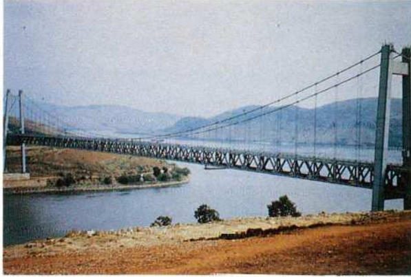
Fig. 8. Le pont de Matadi
