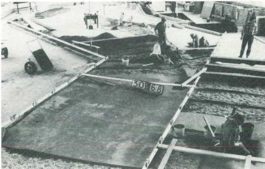
Fig. 1b. Afwerking bodem tussen de dwarsprofielen Achèvement du lit entre les profils en travers
