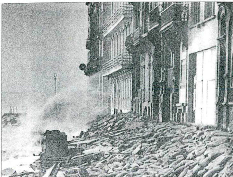
Heist: de strandpromenade is volledig weggespoeld; de (binnendijks) appartementen houden kantje boord de dijk.
