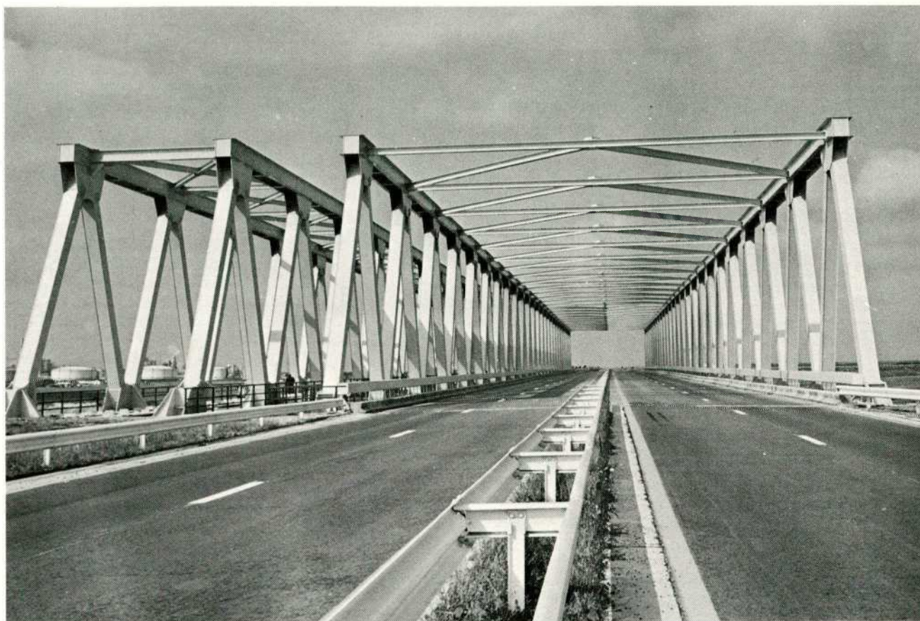
Le pont qui permet de franchir, près de la frontière néerlandaise, la nouvelle liaison Escaut/Rhin, a été conçu pour un trafic à forte densité.
