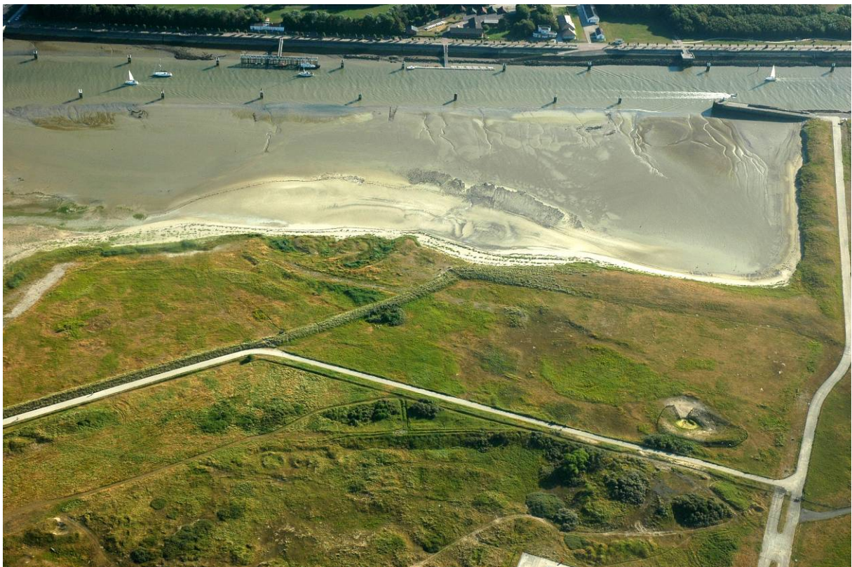
Figuur 32g – Noordelijk deel van de beheereenheid zuid met zicht op het geëgaliseerde duingedeelte (drie duindoornhaarden zijn daar inmiddels verwijderd maar nog herkenbaar als donkergroene vlekken) met gegraven drinkpoel, de drie door zoetwater gevoede ruigtes en de verschillende zones van vloedmerkvegetatie vanuit de lucht op 23 juli 2006, 18:30 uur (1 uur voor laagwater).
