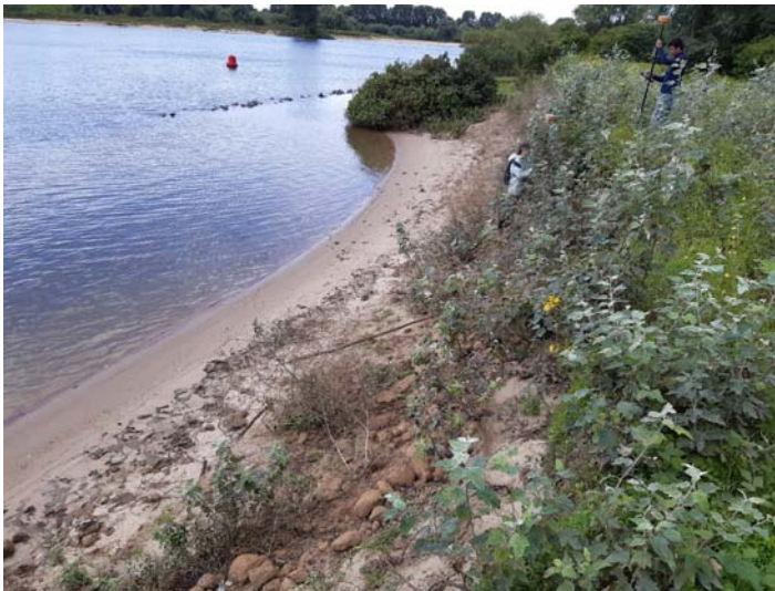
Figuur B.3.4.8: Benedenstrooms brug A2, rechteroever, binnenbocht (geometrie erosie wordt ingemeten door WUR)
