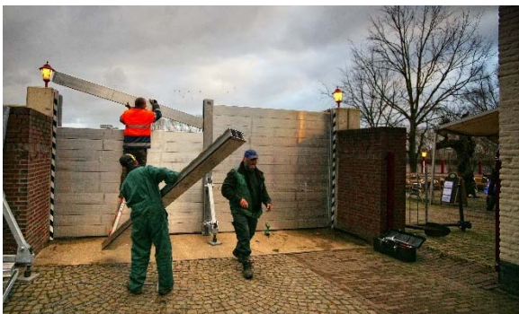
Figuur 7.4: Demontabele kering bij Steyl
