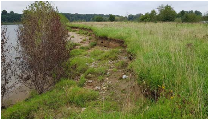
Figuur B.3.4.4: Erosie Rijkelse Bembden, rechteroever
