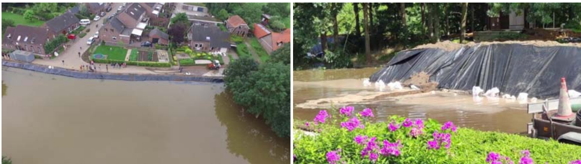
Figuur C.3.1 Nooddijk bij Horn 29 met de latere doorbraaklocatie bij de shovel, en het begin van de doorbraak 30 .
