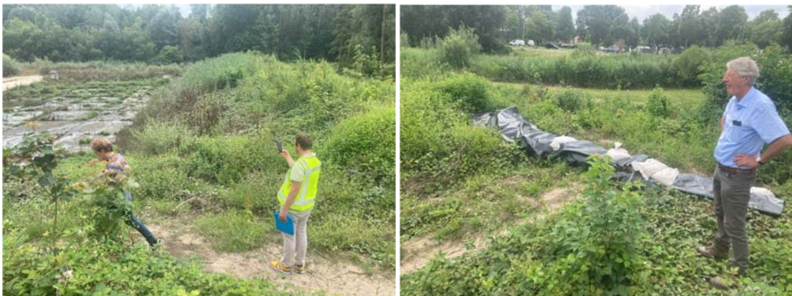
Figuur C1.1: Waterbergingsgebied De Dem met op de linkerfoto rechts onder de vermoedelijke uitstroomlocatie, op de rechterfoto op de voorgrond de sporen van erosie van dezelfde locatie.
