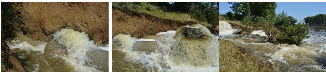
Figuur C.8.1: Zeven Ellen Waterlaat nabij Horn, boven: situatie op 21 juli (foto's Erik Bijlsma, Rijkswaterstaat), onder: situatie op 23 juli bij een peil in het retentiegebied circa 1,95 onder de piekwaterstand
