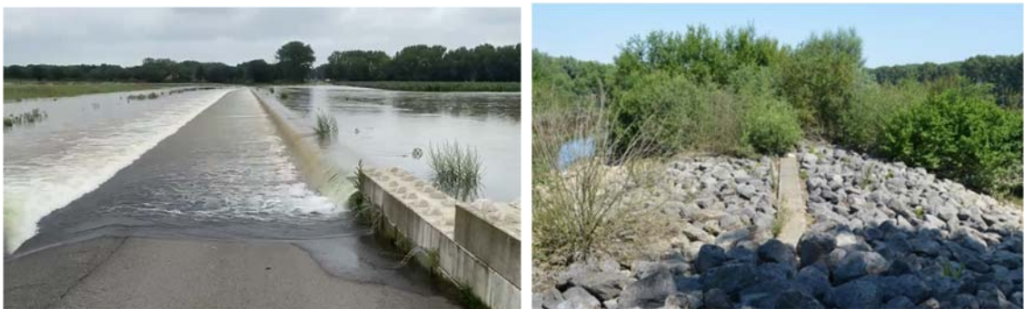
Figuur B.1.6.1: Inlaatdrempels van retentiegebied LKW. Links de inlaat van het zuidelijk bekken tijdens het hoogwater, gezien vanuit het noorden. 23 Rechts de inlaat van het noordelijk bekken na het hoogwater, gezien vanuit het noorden.
