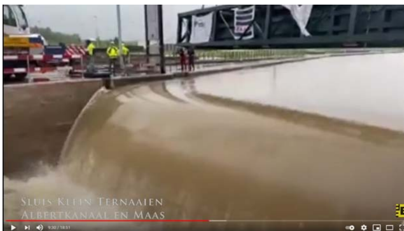
Figuur B.1.10.1: Afvoer over sluis Ternaaien. Opname uit video: https://youtu.be/3Kx0s0JU0T1?t=571
