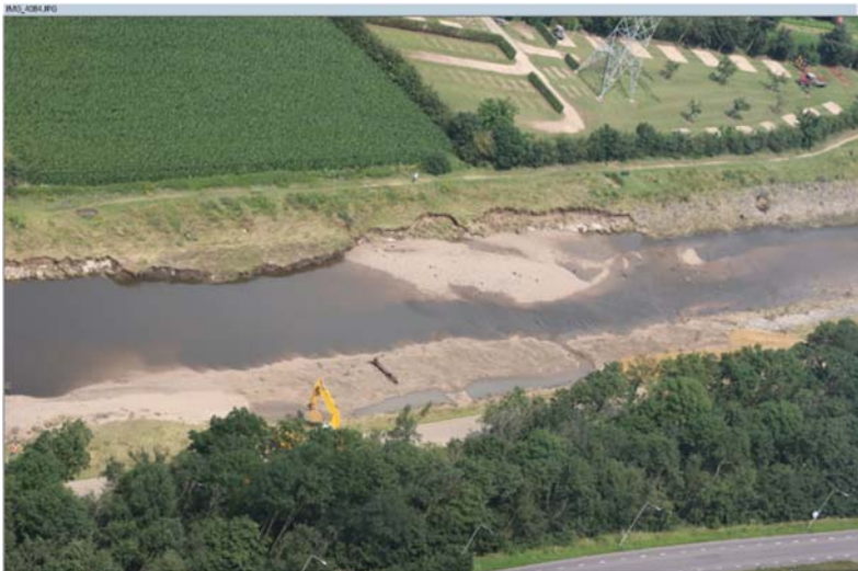
Figuur B.3.6.2: Helicopterfoto herstelwerkzaamheden
