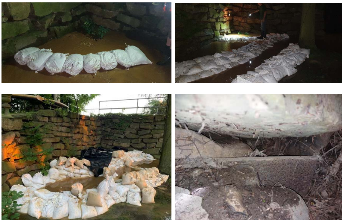
Figuur 4.7: Keersluis Roer, met achtereenvolgens afgezet zand en grind bij de eerste zandzakken (foto Guido van Rinsum, Witteveen+Bos), opkisting op 17 juli om 4:30 uur (foto Guido van Rinsum, Witteveen+Bos), opkisting op 17 juli rond 20:00 uur (foto Guido van Rinsum, Witteveen+Bos), de slechte aansluiting van de sluisconstructie op de bovenkant van de damwand aan de hoogwaterzijde.
