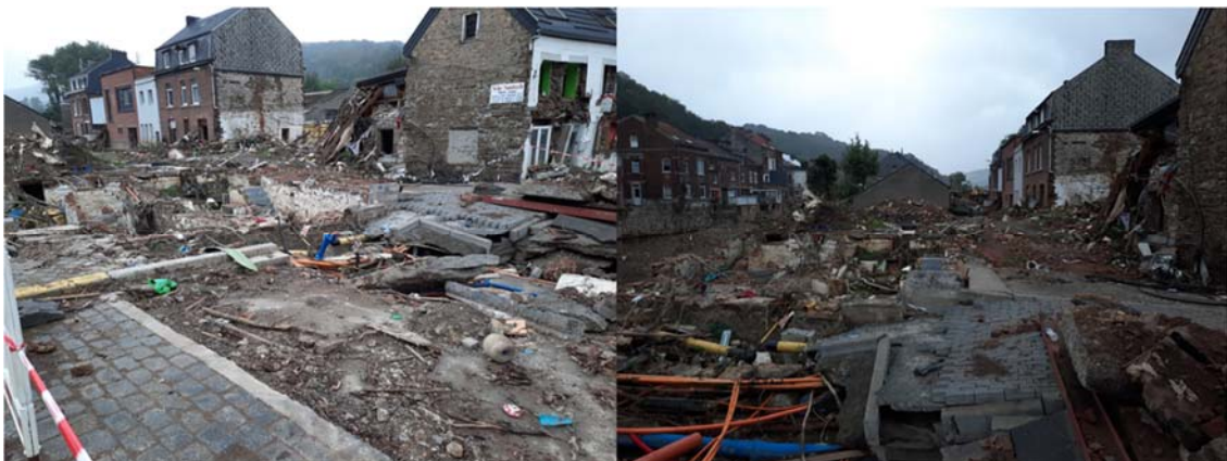
Figuur 8.3: Schade aan wegen en gebouwen in Pepinster (Bron: Deltares collega's, genomen tijdens GEER-missie.)
