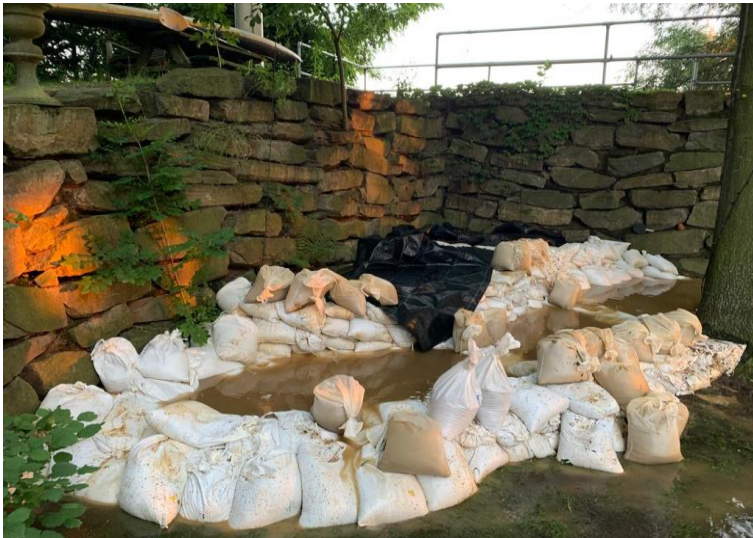
Zandmeevoerende wellen: Keersluis Roer
