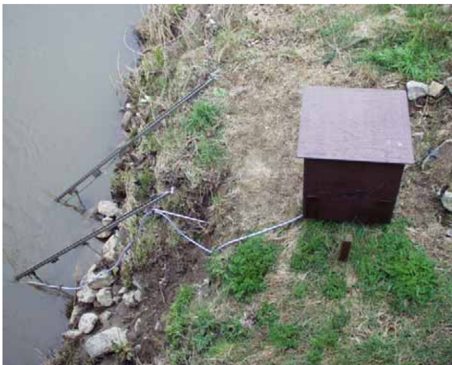
Figuur 5.12: Van op de brug ziet men duidelijk de twee rails in de schuine kant van de oever staan, onderaan de foto ziet men de rail met het aanzuigstuk van het staalname-apparaat, er boven de geleidingsrail voor de sonde.
