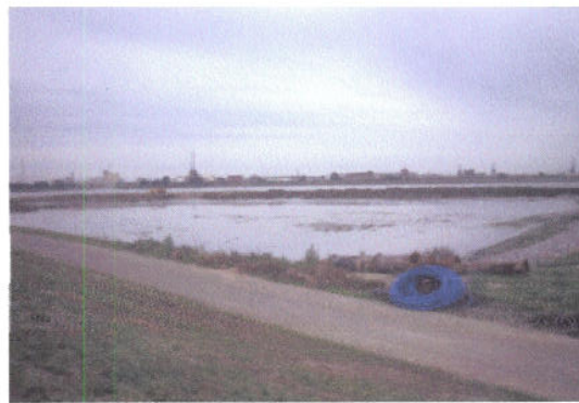
Overzicht van het slibbekken
