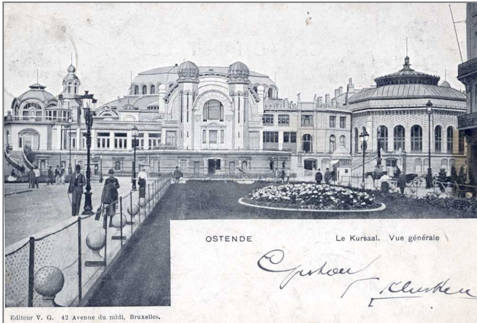
10 - Het tweede Kursaal, ontworpen door architect Naert (SAO PKIB0192)
