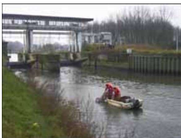
Foto 2e-en 2f: respectievelijk van het sluis-stuwcomplex van Merelbeke (inclusief stuwgeul en afsplitsing naar de Tijarm) en van de stuw op de Tijarm
