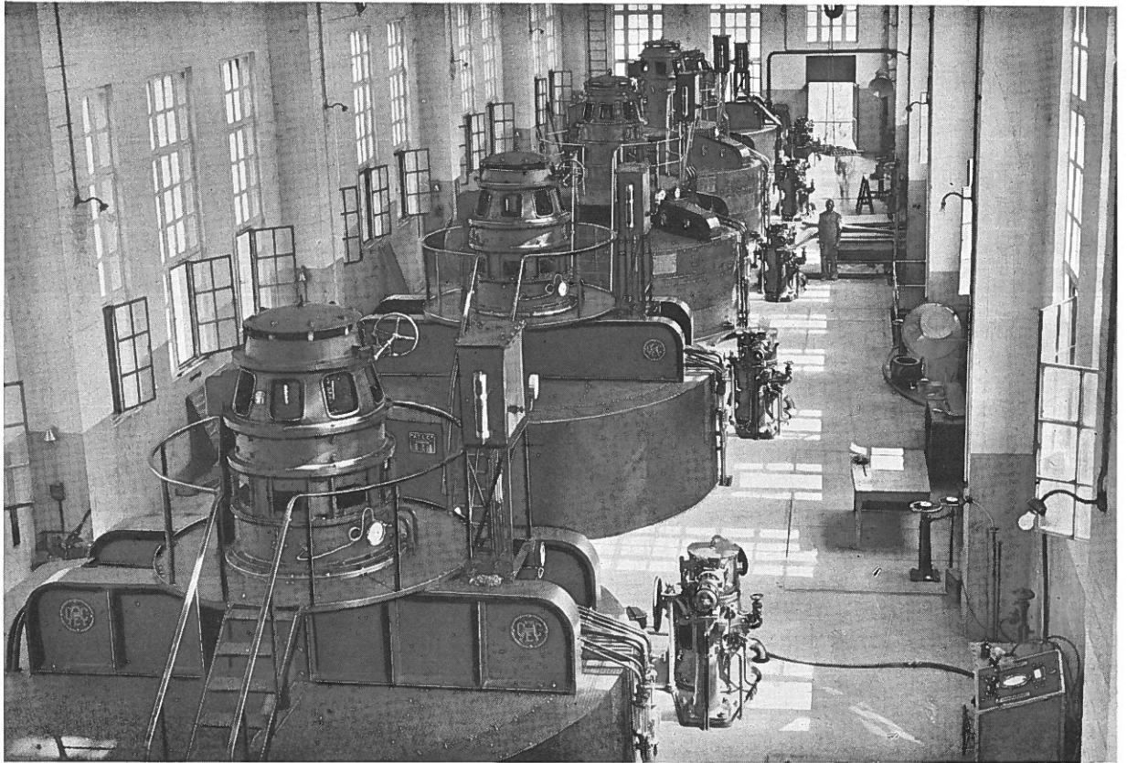
Centrale Francqui sur la Lufira - Salle des alternateurs.
