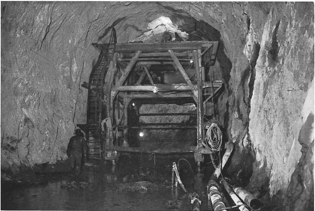
Centrale Le Marinel - Creusement de la galerie d'amenée.
