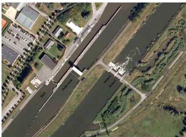
Figuur 6: Stuwen en sluizen aan de visnevengeul te Oudenaarde.
