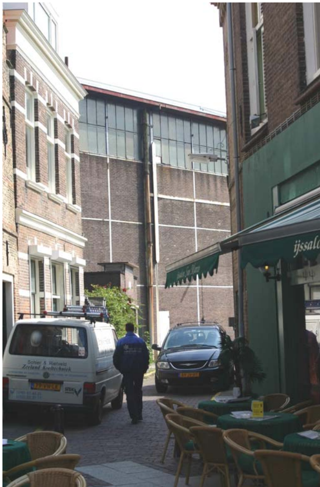
De zuidmuur van de zware plaatwerkerij vormt een imposante afscheiding tussen de stad en het Scheldeterrein. Dit deel van de zware plaatwerkerij werd gebouwd in 1929, later werd het verlengd tot een totale lengte van ongeveer 400 meter. Het gebouw blokkeert het oude stratenpatroon van de binnenstad.
