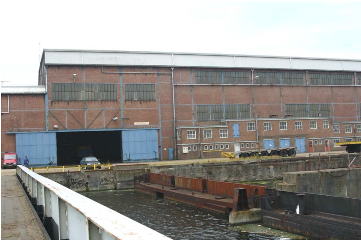
Het oudste deel van de zware plaatwerkerij, een van de gebouwen rond de Dokhaven met duidelijke 'Scheldekenmerken': een groot bouwvolume en muren bestaande uit een stalen vakwerk, opgevuld met bakstenen.
