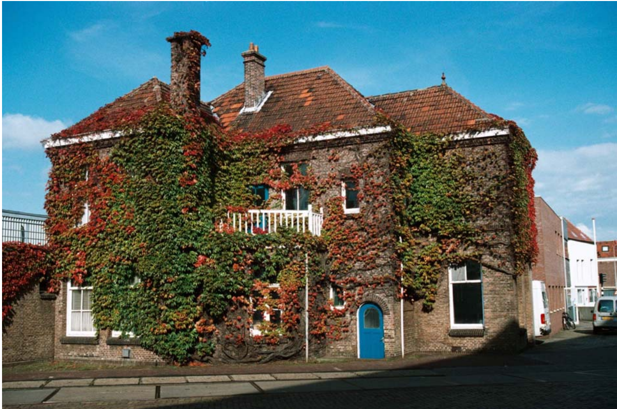
De 'verbandkamer', later de plaats waar de kern van de Centrale Ondernemingsraad zitting hield.
