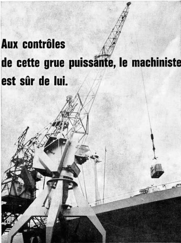
Une des onze grues en voie de construction dans le Port de Rotterdam.
