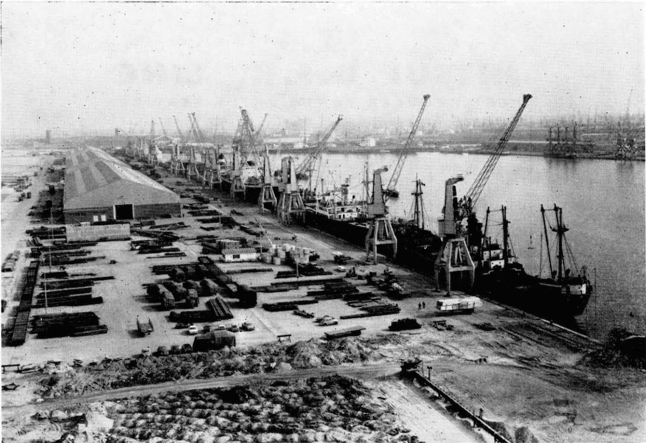
Ansicht vom 6. Hafenbecken ; Gezicht op het 6de Havendok ; Kräne mit 5 t Hubvermögen 5 t stukgoedkranen met 32 m mit einem Aktionsradius von reikwijdte. 32 m für Stückgüter.
