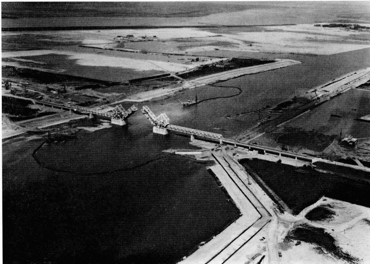
Aerial photograph Canal-Bridge Luchtfoto Kanaalbrug (8.6.1967)
