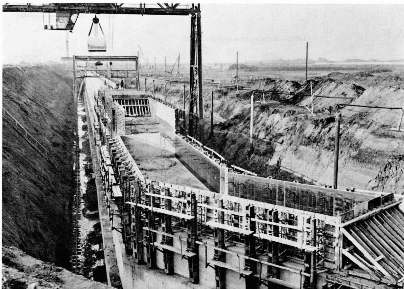
Bau einer Kaimauer (7.11.1961)
