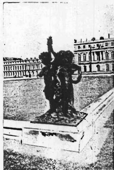
L'AILE DU NORD, VUE DU PARTERRE D'EAU
