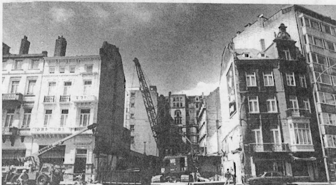
Het zo bekende Oostendse tankstation Ocean aan de Koningstraat te Oostende is van de aardbol verdwenen. Enkele dagen geleden werd het tankstation met de grond gelijk gemaakt. De Ocean werd enkele jaren geleden door dieven overvallen die er met de kassa van door gingen doch later bij de lurven werden gevat. Het tankstation was ook vooral bekend omdat men er dag en nacht terecht kon. (jjs)
