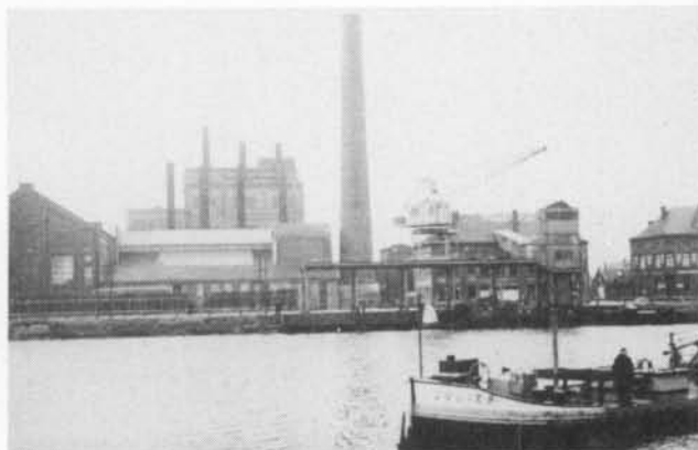
De elektriciteitscentrale van Sas-Slijkens
