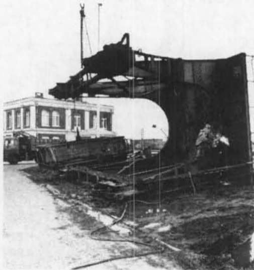
In Oostende verdween een brok industriële archeologie. Twee oude kranen aan de Oostkaai (Vlotdok) werden door sloper Gilbert Deschrijver uit Zeebrugge in een minimum van tijd tot schroot herleid. (gw)
