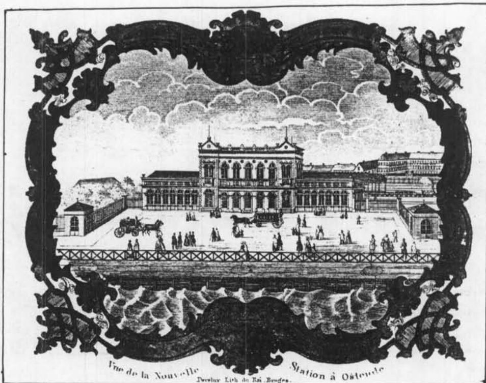
Fig. nr. 5c-porceleinkaart, uitg. Daveluy, met zicht op het eerste spoorwegstation aan het 2e Handelsdok. Het station is geflankeerd door de twee octrooigebouwtjes. Op de voorgrond het dok met op de kaai het goederenspoor. Bemerkt de reling met hekkens om de voetgangers te beveiligen, (1950).
