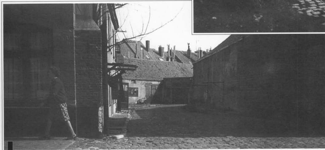
3. Slop in de Leffingestraat nabij Gerststraat/Hennepstraat; gesloopt en dichtgebouwd in 1981 (foto: 09.08.1976)
